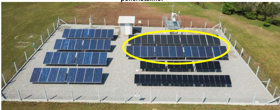
Figura 36 - Estação de geração em solo, em específico demarcado a tecnologia de policristalino.
