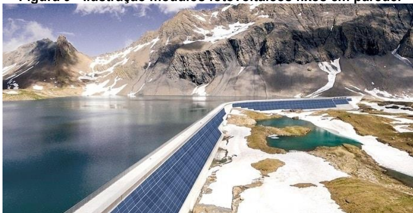
Figura 9 - Ilustração módulos fotovoltaicos fixos em parede.
