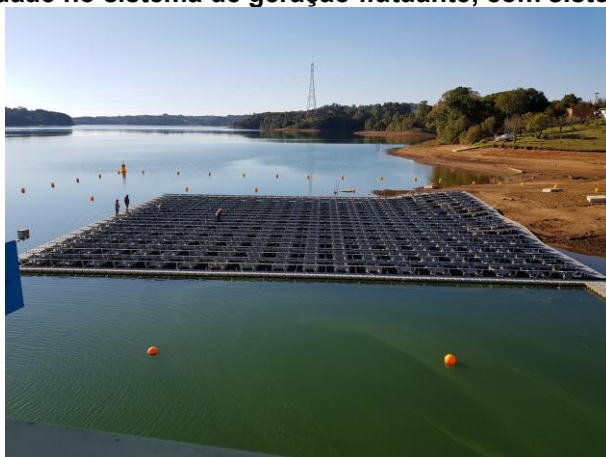
Figura 50 – Adversidade no sistema de geração flutuante, com sistema apoiado em solo.
