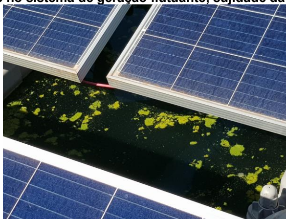
Figura 54 – Adversidade no sistema de geração flutuante, sujeira da água sob as instalações.
