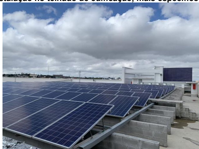
Figura 41 - Instalação no telhado de edificação, mais específico dos sistemas.
