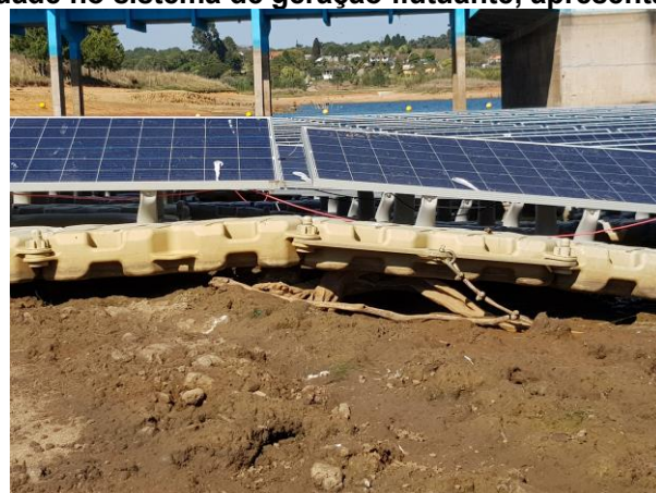
Figura 52 – Adversidade no sistema de geração flutuante, apresentando ângulo em solo.
