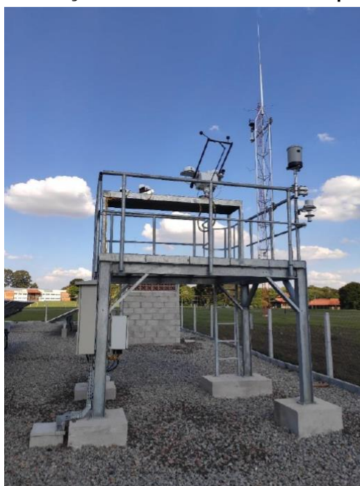
Figura 42 – Estação solarimétrica SONDA campus Curitiba
