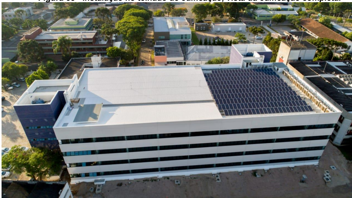
Figura 38 - Instalação no telhado de edificação, vista da edificação completa.
