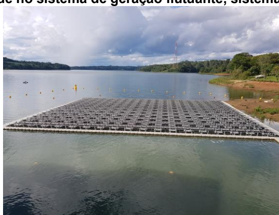
Figura 58 - Adversidade no sistema de geração flutuante, sistema semi apoiado em solo.
