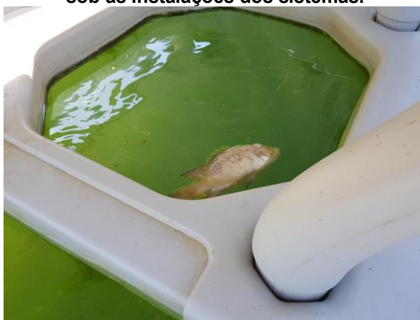
Figura 55 – Adversidade no sistema de geração flutuante, acúmulo de material não apropriado sob as instalações dos sistemas.
