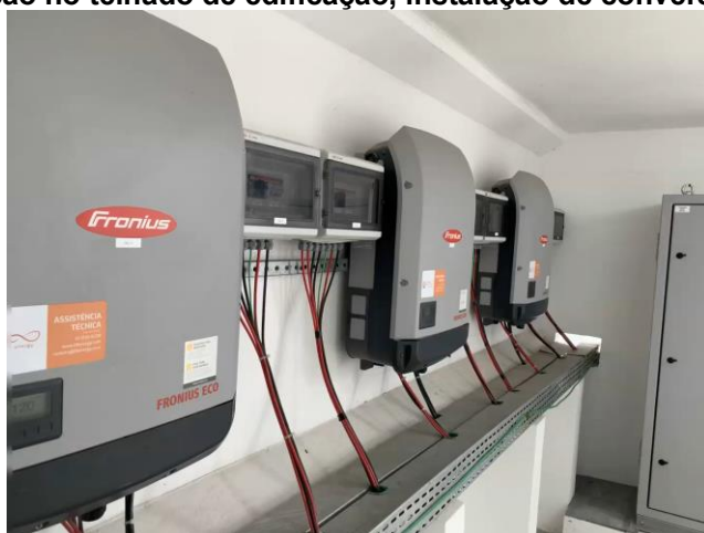
Figura 39 - Instalação no telhado de edificação, instalação de conversores de frequência.
