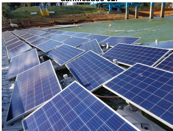
Figura 49 – Adversidade no sistema de geração flutuante, com módulos fora da posição e danificados 02.
