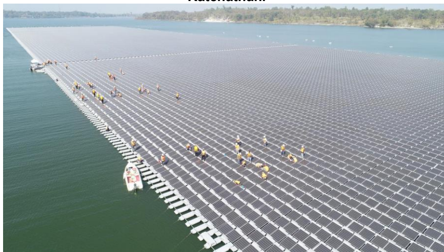
Figura 28 – Implantação da fazenda solar flutuante na barragem de Sirindhorn em Ubon Ratchathani
