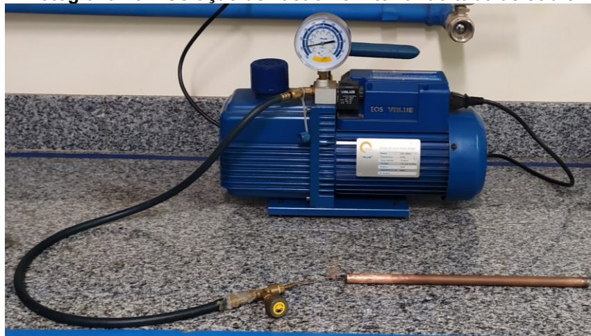
Fotografia 13 – Geração de vácuo no interior do tubo de cobre
