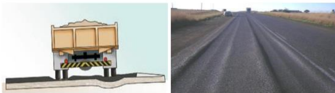
Figura 5 – Deformação Permanente, afundamento de trilha de roda
