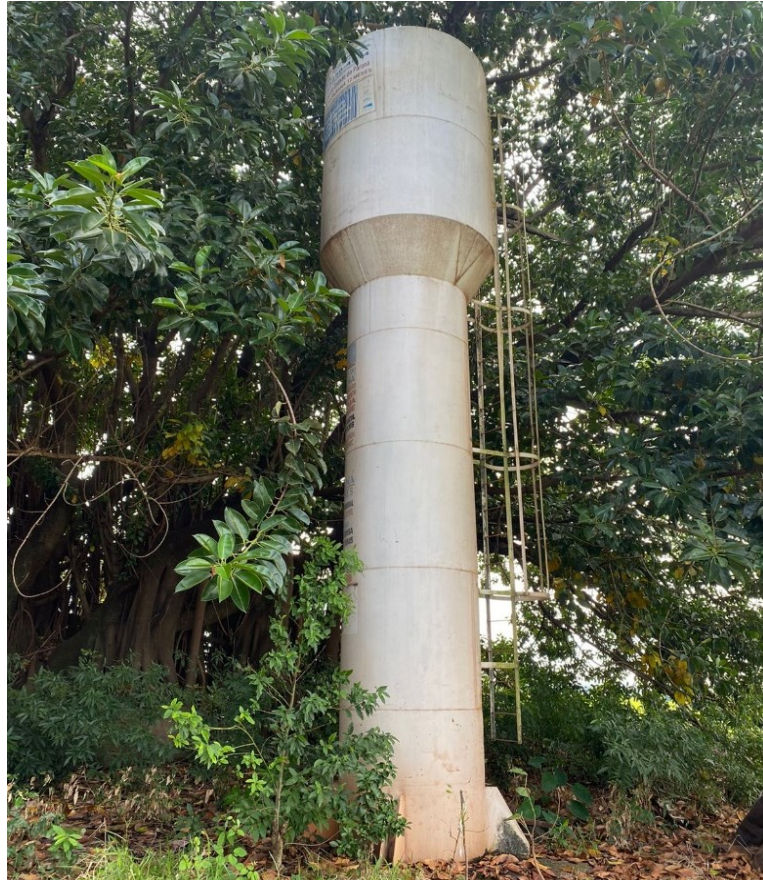
Figura 16 – Sistema de armazenamento de água das comunidades de São Marcos, Takao e Caracol
