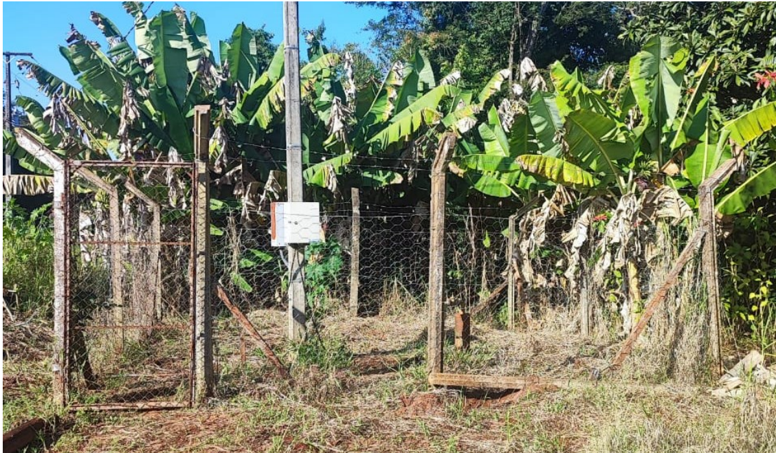
Figura 19 – Sistema de captação de água da comunidade de São Roque
