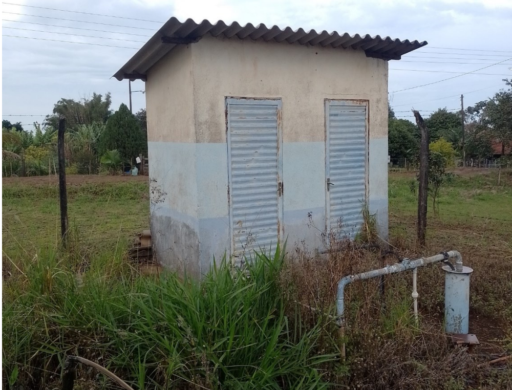
Figura 31 – Vista da casa de bombas da Vila Rural de Bragápolis
