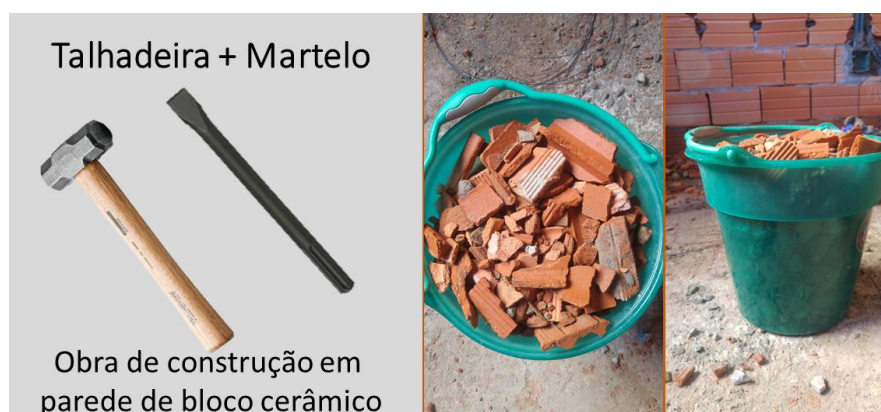
Figura 31 – Resíduo de parede bloco cerâmico utilizando a talhadeira e o martelo para corte
