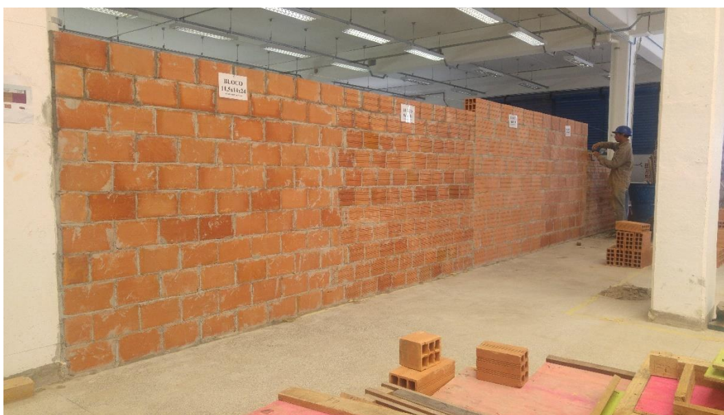
Figura 23 – Construção da parede no canteiro de obras
