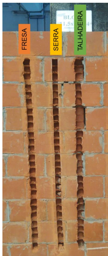
Figura 33 – Comparação das larguras e do acabamento do rasgo para as diferentes ferramentas
