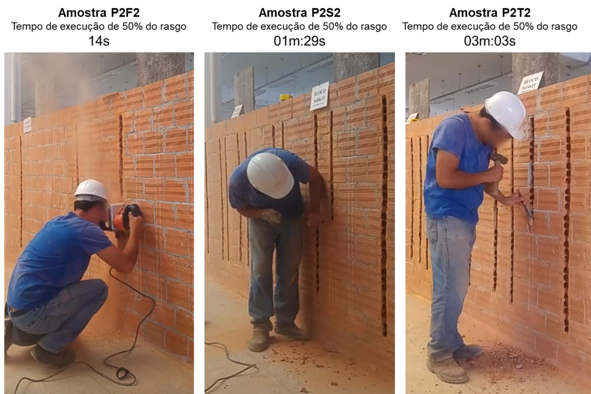
Figura 32 – Comparação entre os tempos de fresa, serra mármore e talhadeira para 50% de um rasgo
