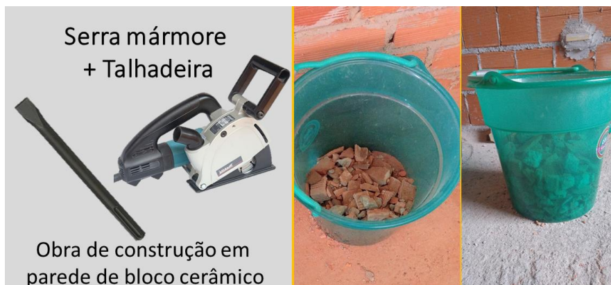
Figura 30 – Resíduo de parede de bloco cerâmico utilizando a serra mármore e a talhadeira para corte
