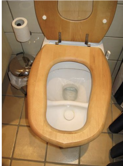
Fotografia 2: Modelo de sanitário com separador de urina
