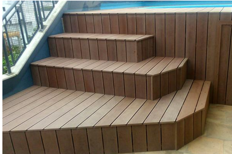
Fotografia 4: Escada e deck em área externa
