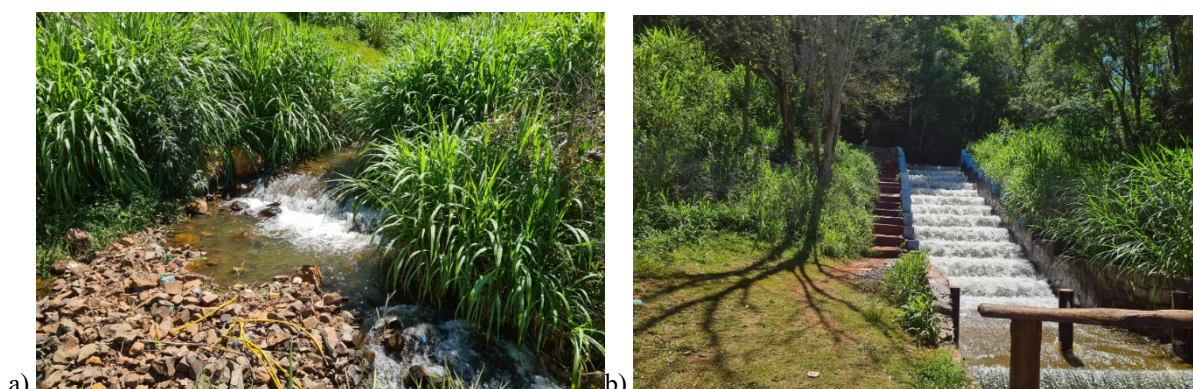
Figura 18 - Registro fotográfico da Seção 1 - Ribeirão da Raposa, a) Detalhe de processo de assoreamento do curso d'água; b) Dissipador de energia em modelo de escada.
