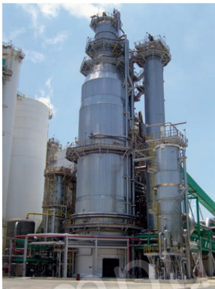
Figura 2 - Digestor contínuo na Veracel no Brasil fabricado com duplex 2205.
