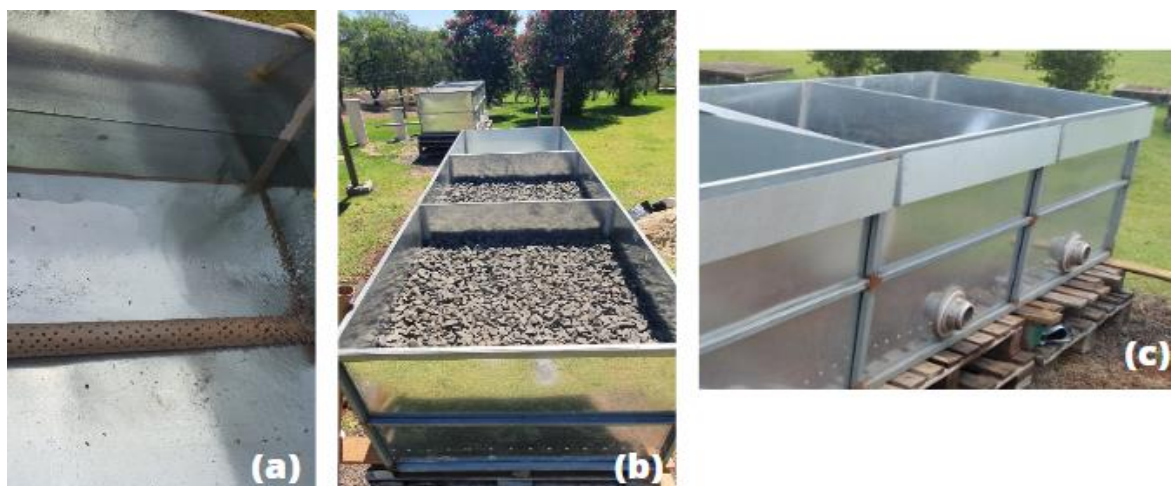
Figura 9: Etapas de execução dos módulos: (a) teste de estanqueidade, (b) camada de armazenamento, (c) instalação das calhas.
