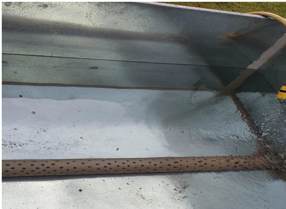
Figura 13: Dreno de fundo instalado próximo a base da estrutura que delimita os pavimentos permeáveis.
