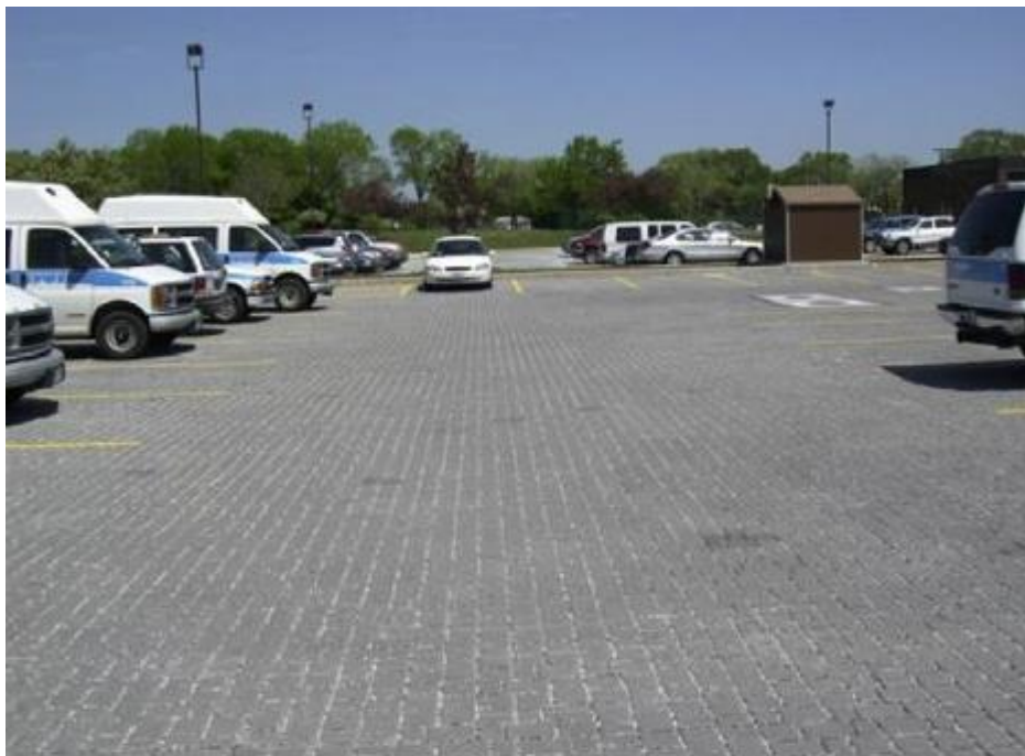
Figura 1: Estacionamento em pavimento permeável.
