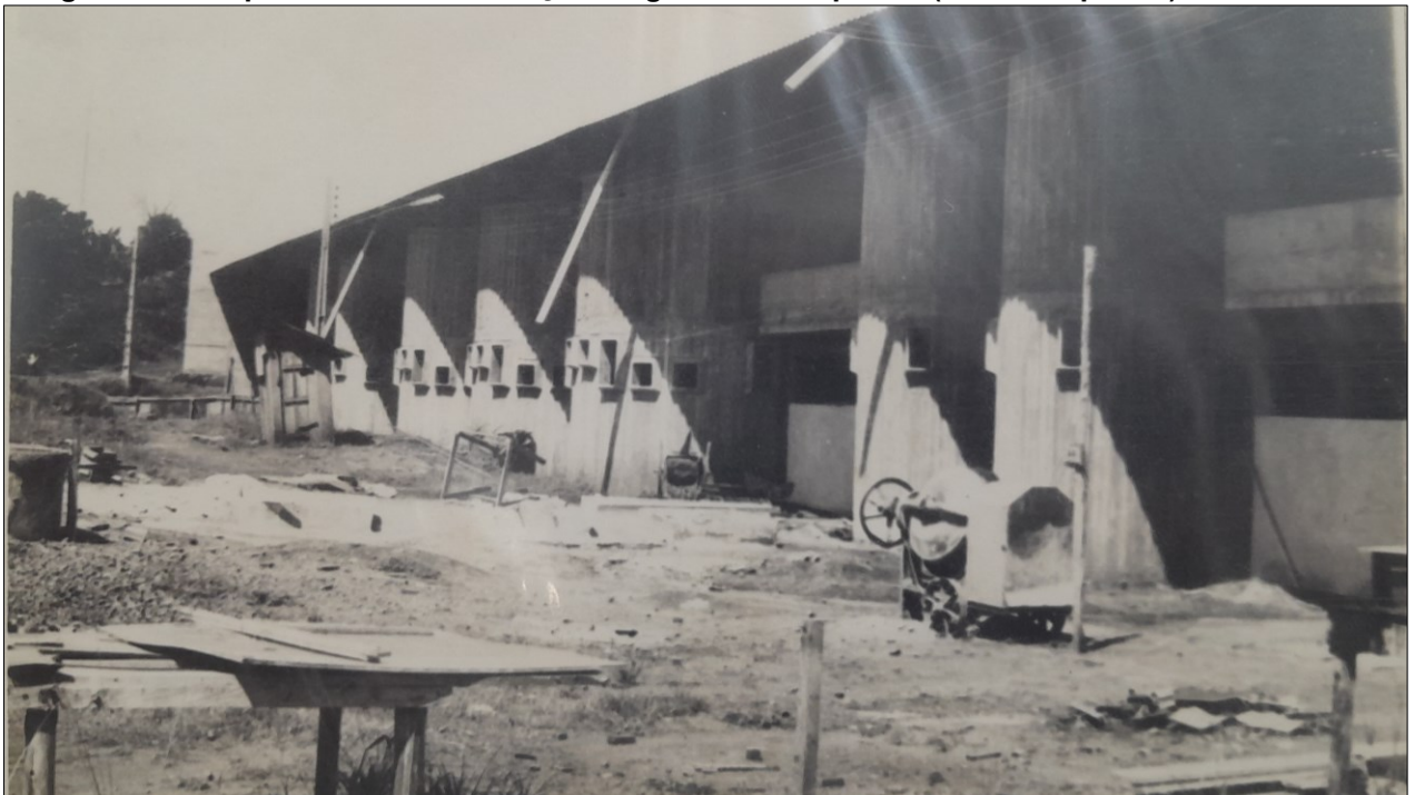
Figura 28 – Etapas finais da construção do ginásio de esportes (lateral esquerda) em 1976.
