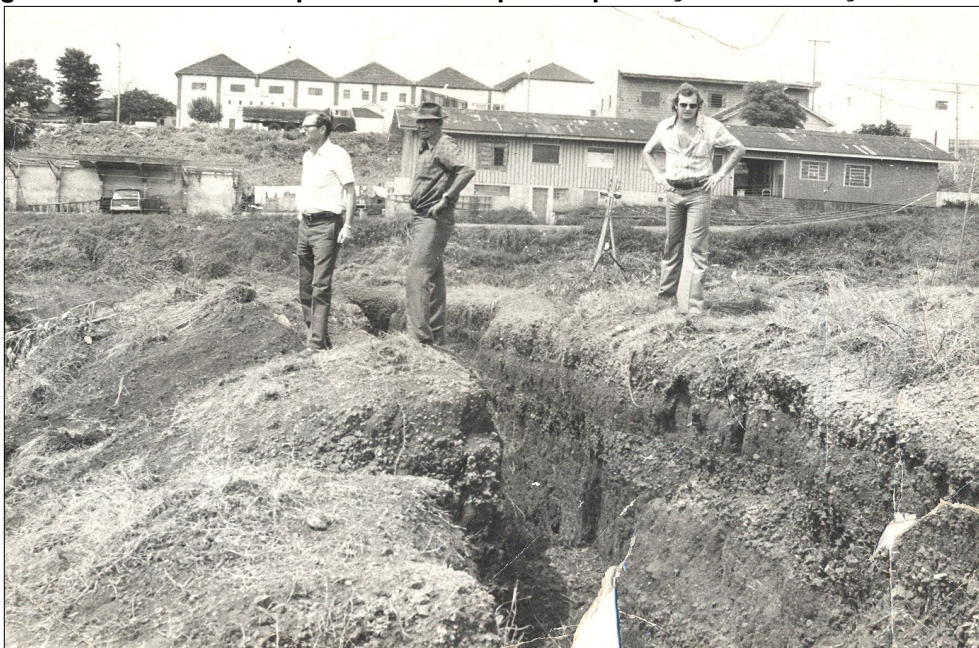
Figura 23 – Abertura das primeiras valas para implantação da tubulação em 1975.
