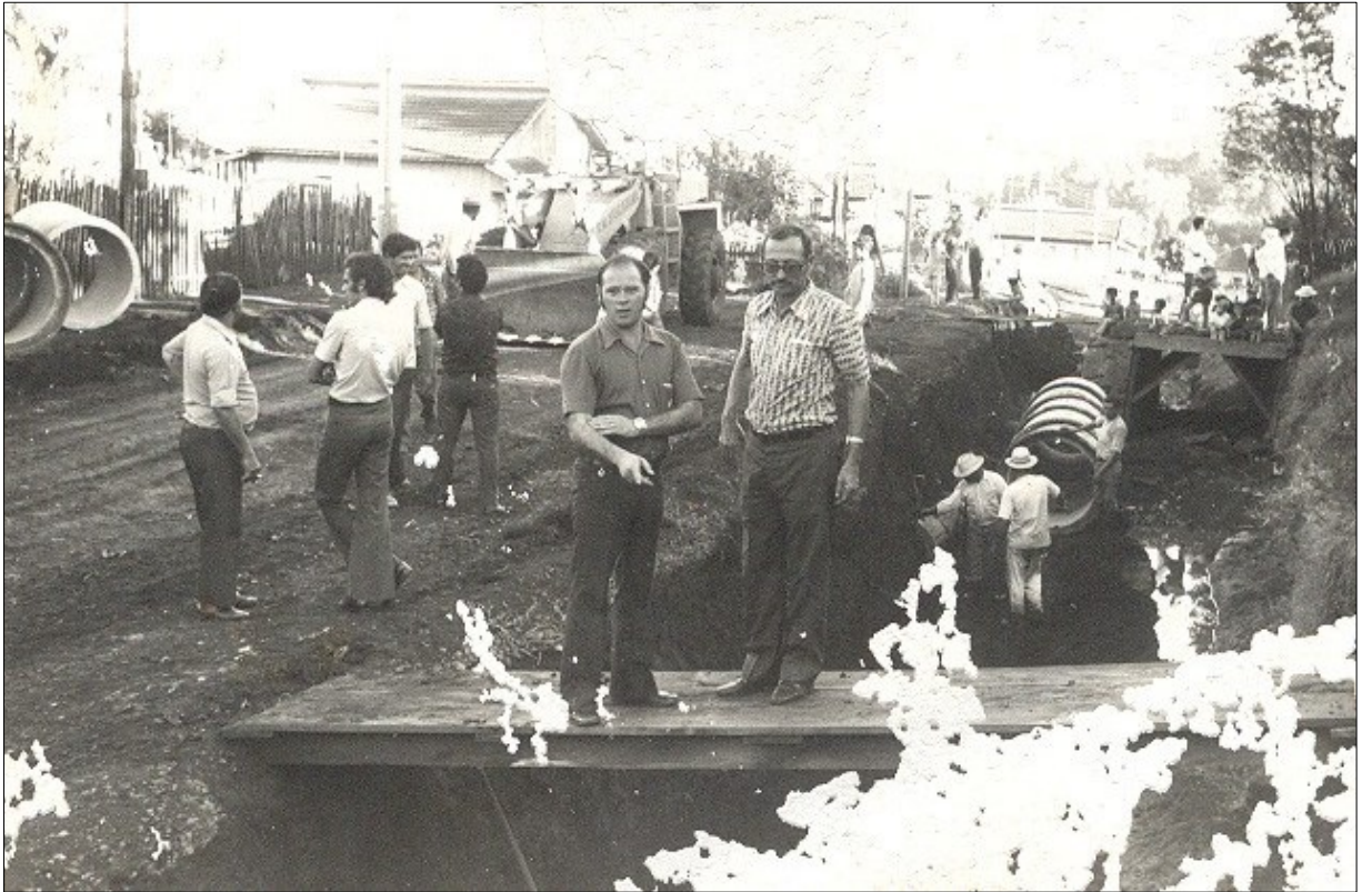
Figura 24 – Início da colocação dos tubos de drenagem em 1975.
