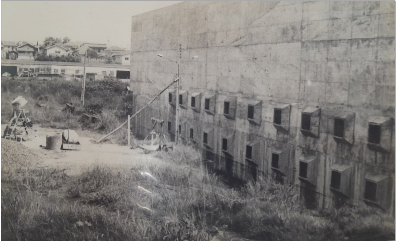
Figura 27 – Etapas finais da construção do ginásio de esportes (lateral direita) em 1976.
