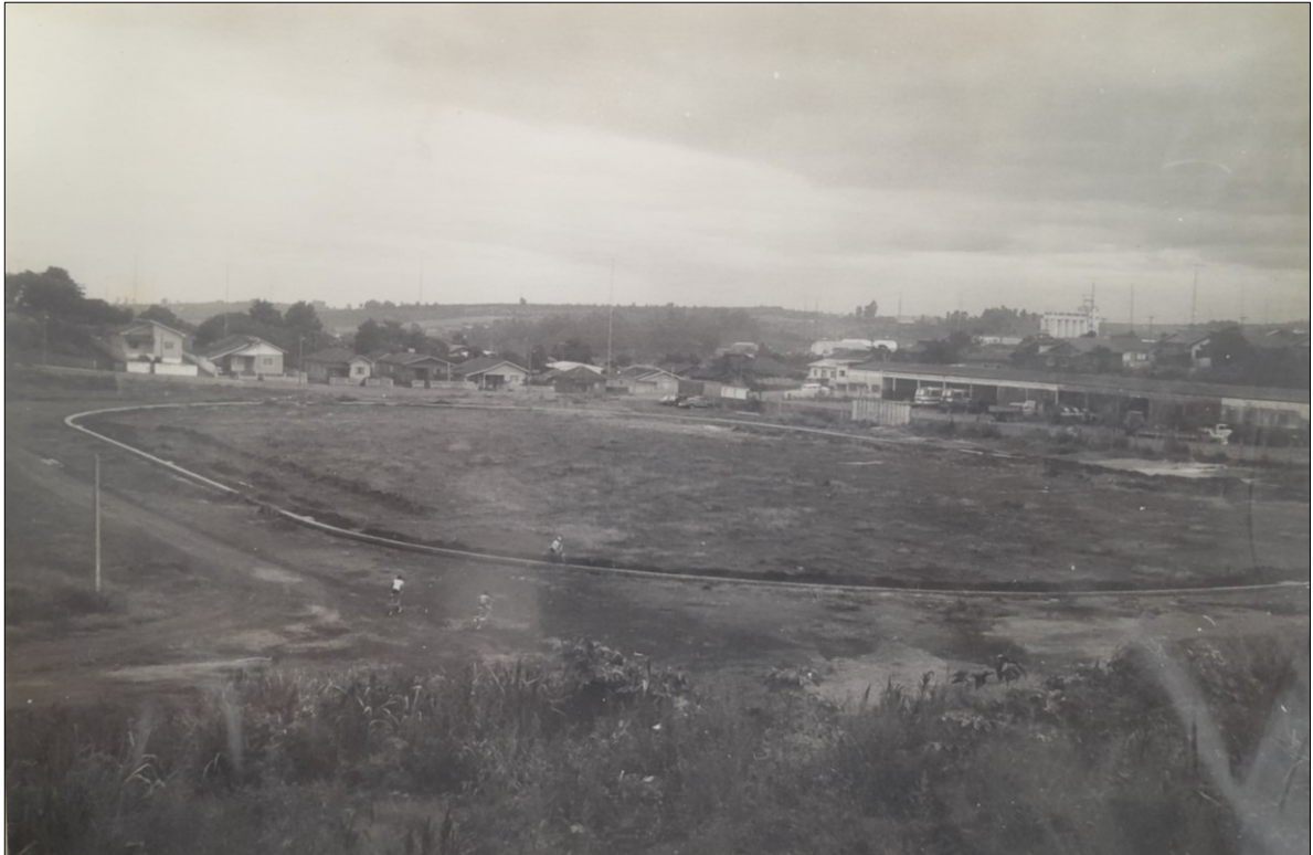
Figura 36 – Construção da pista de atletismo em 1981.
