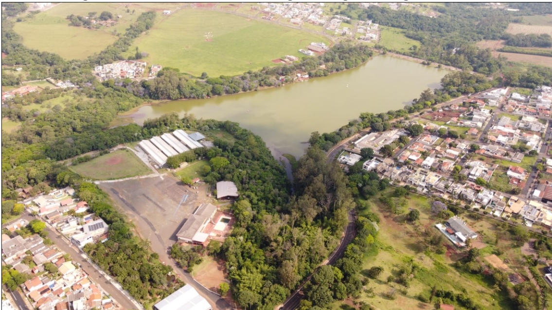
Figura 40 – Exutório da bacia hidrográfica Água da Lagoa em 2023.
