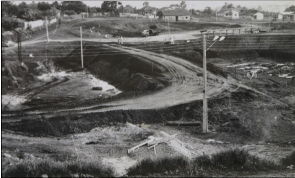
Figura 22 – Início da terraplanagem para a construção em 1971.
