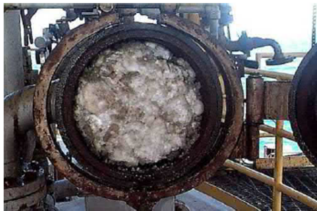
Figura 4 – Interrupção total em uma linha de produção devido à formação de hidratos.
