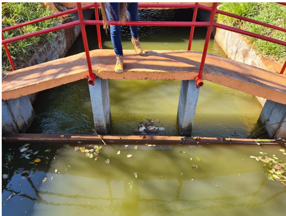
Figura 27 - Entrada do Canal Hidráulico
