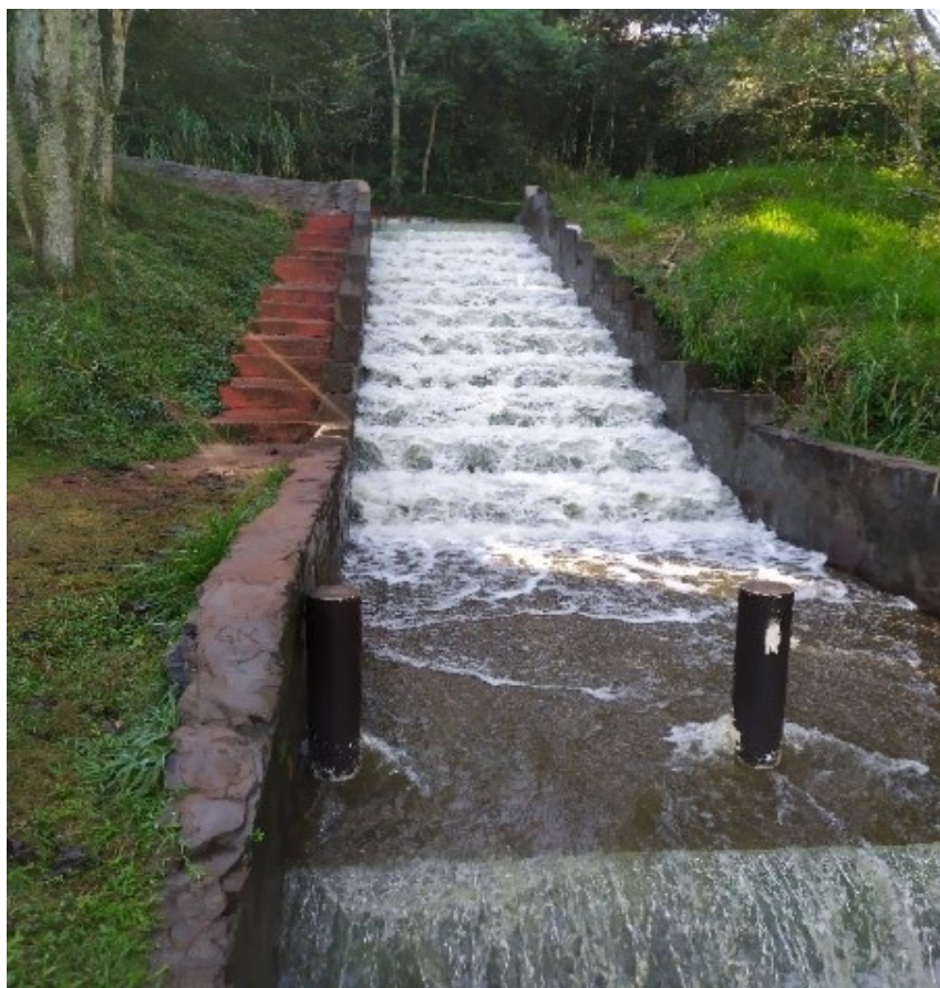
Figura 29 - Dissipador de Energia
