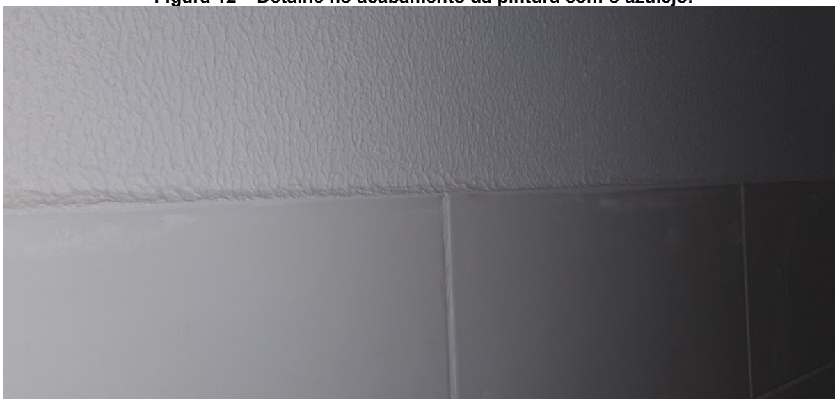
Figura 12 – Detalhe no acabamento da pintura com o azulejo.
