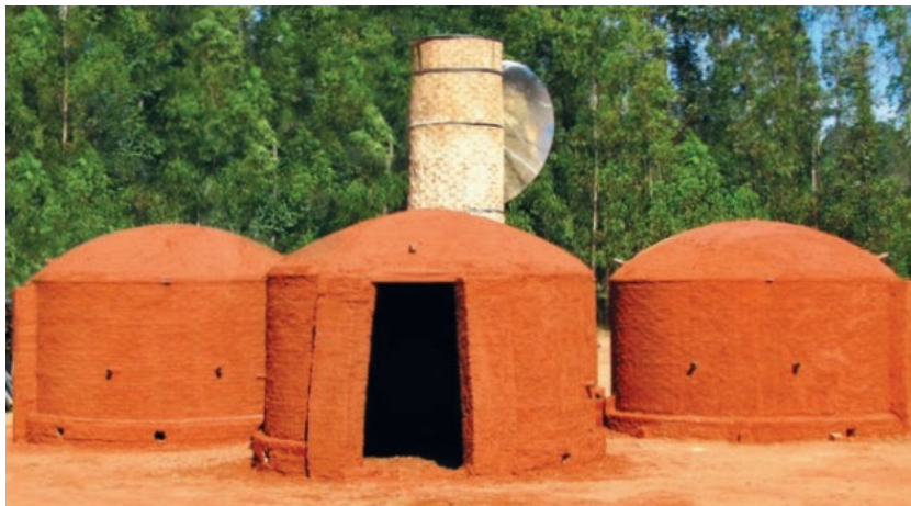
Figura 3 – Forno superfície (sistema forno-fornalha)
