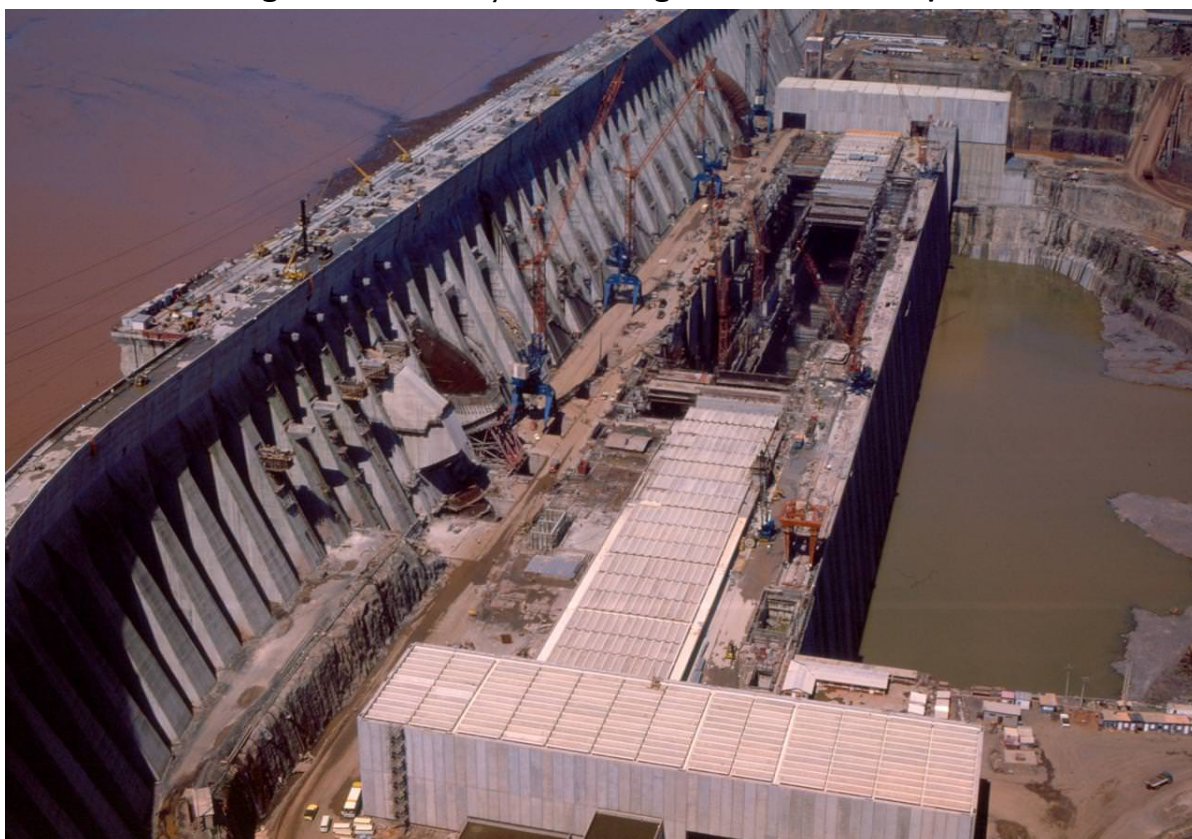
Figura 1 – Construção da barragem da usina de Itaipu.
