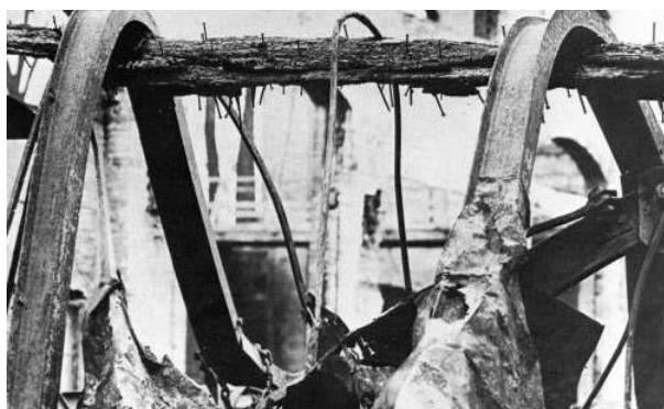
Figura 14 - Vigas em aço e madeira após incêndio, [41].
