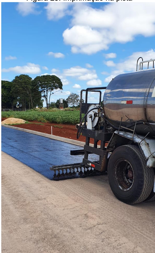
Figura 29: Imprimação na pista
