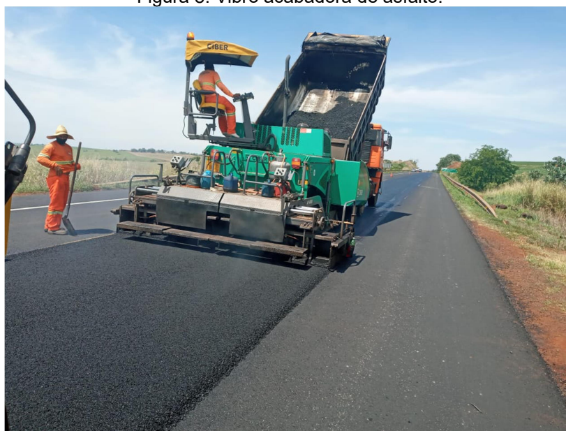
Figura 8: Vibro acabadora de asfalto.
