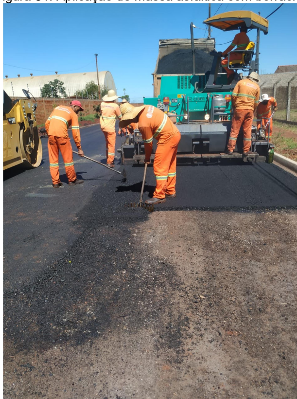
Figura 31: Aplicação de massa asfáltica com borracha.
