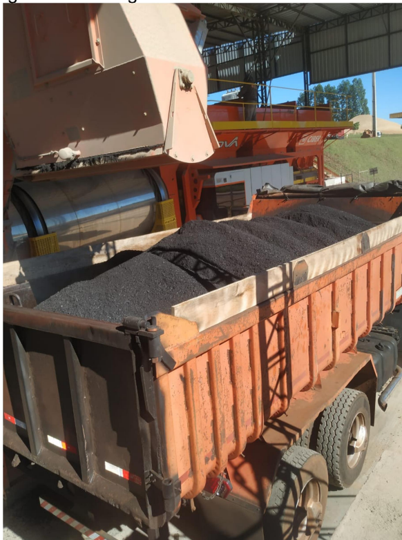
Figura 27: Usinagem mistura asfáltica convencional.
