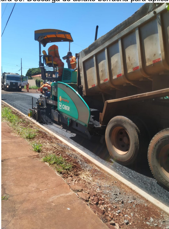
Figura 30: Descarga do asfalto borracha para aplicação.
