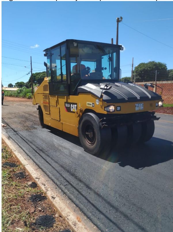
Figura 33: Compactação da pista com o rolo pneu.
