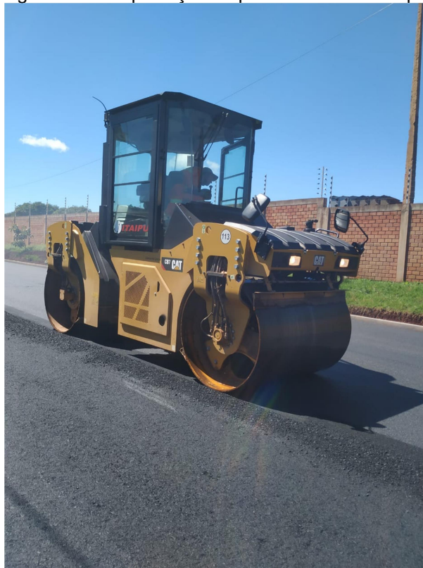
Figura 32: Compactação da pista com o rolo chapa.
