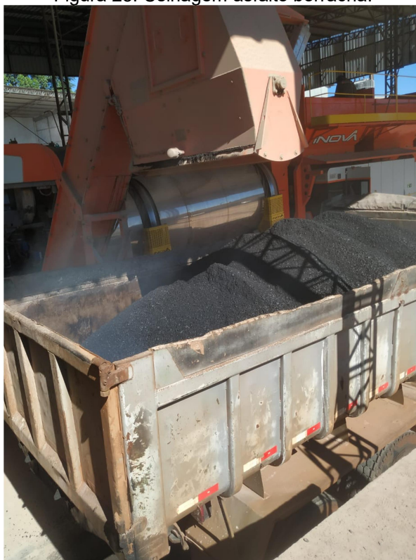
Figura 28: Usinagem asfalto borracha.
