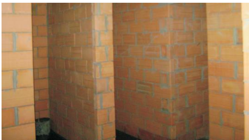
Figura 2: Alvenaria de vedação em blocos cerâmicos
