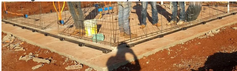
Figura 14: Cantoneiras de marcação para as formas metálicas
