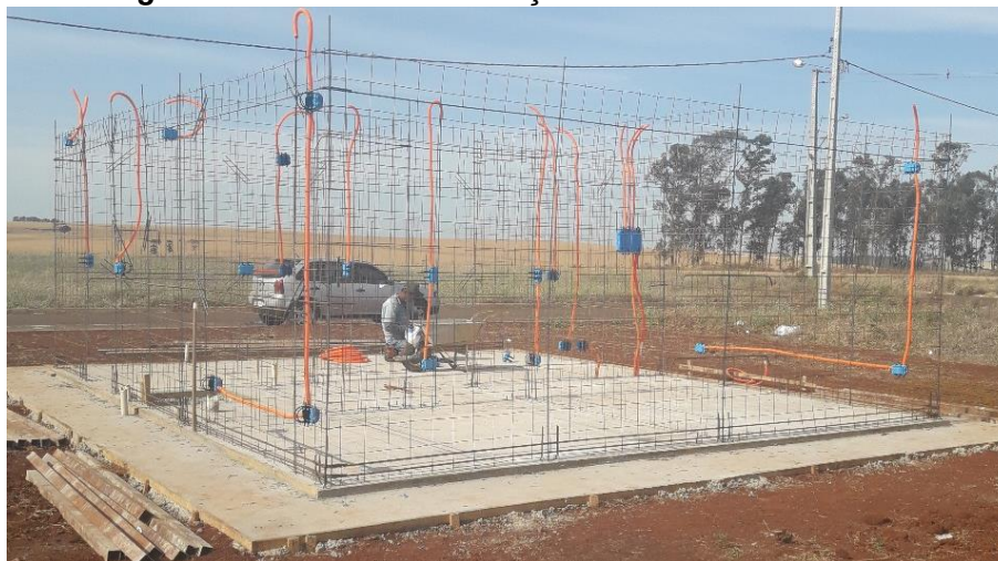
Figura 15: Armadura e instalações hidráulicas e elétricas
