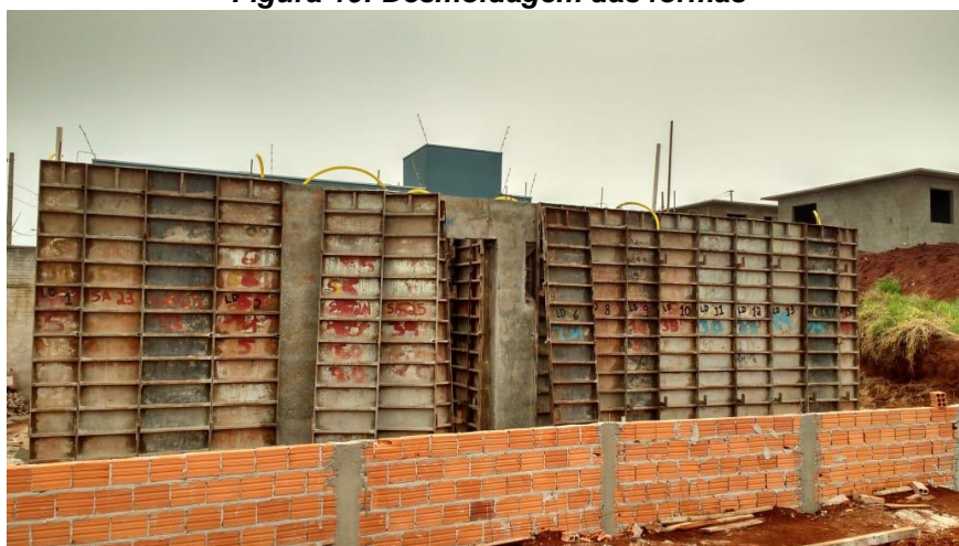
Figura 19: Desmoldagem das formas
