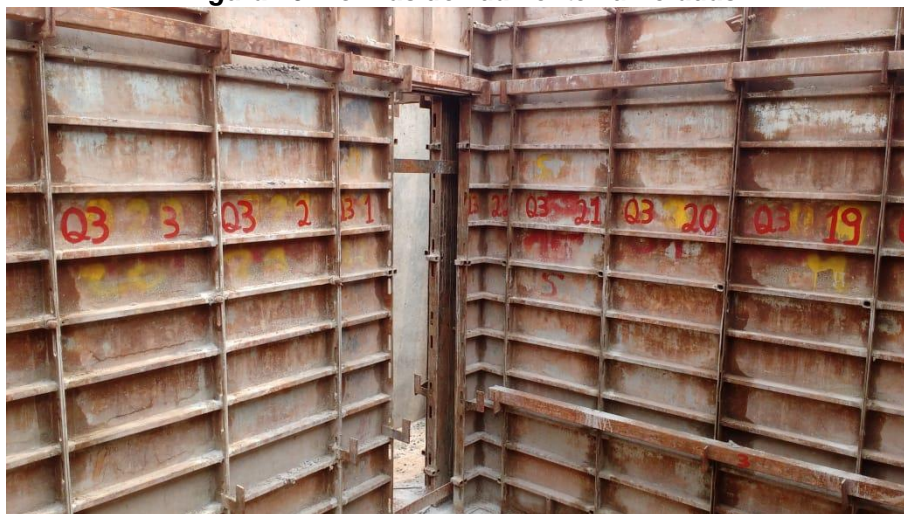
Figura 16: Formas devidamente numeradas
