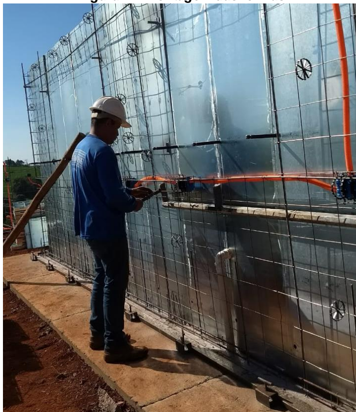
Figura 17: Montagem das formas
