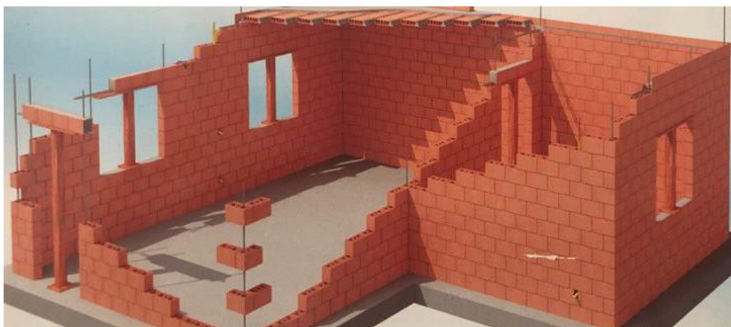
Figura 1: Execução de alvenaria cerâmica estrutural
