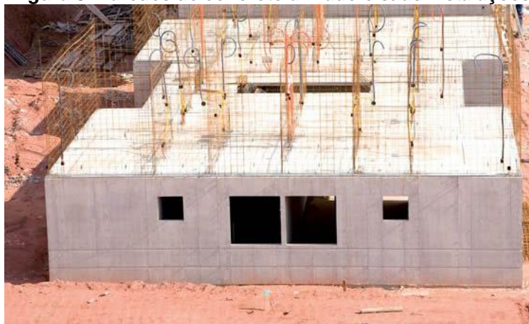
Figura 8: Paredes de concreto armado e suas instalações
