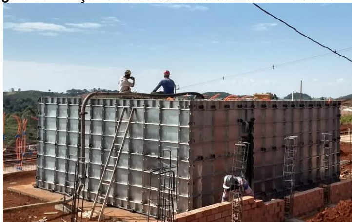
Figura 18: Lançamento do concreto com o auxílio de bombas
