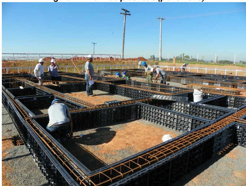
Figura 12: Formas plásticas (polietileno)
