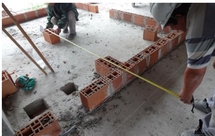
Figura 3: Demarcação da alvenaria
