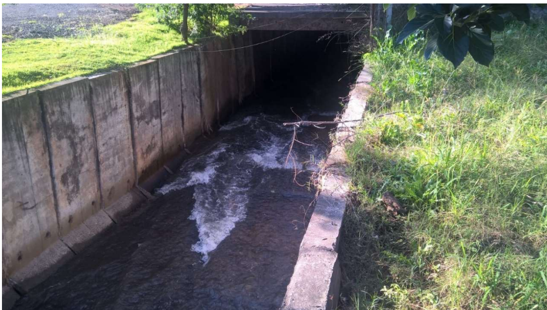
Figura 13 - Último ponto antes da canalização fechada do Córrego Fundo.
