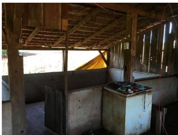
**Figura 12 – Barracão de 5m x 4m com contrapiso e cobertura com telhas de barro.**
