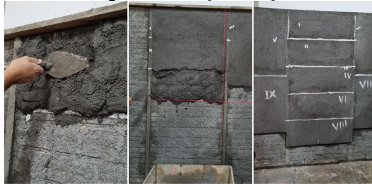
Figura 35 - Execução Emboço
