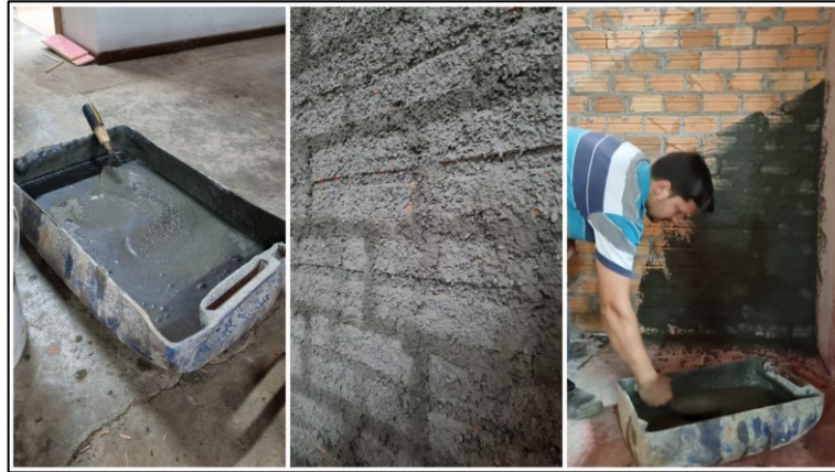
Figura 33 - Execução Chapisco
