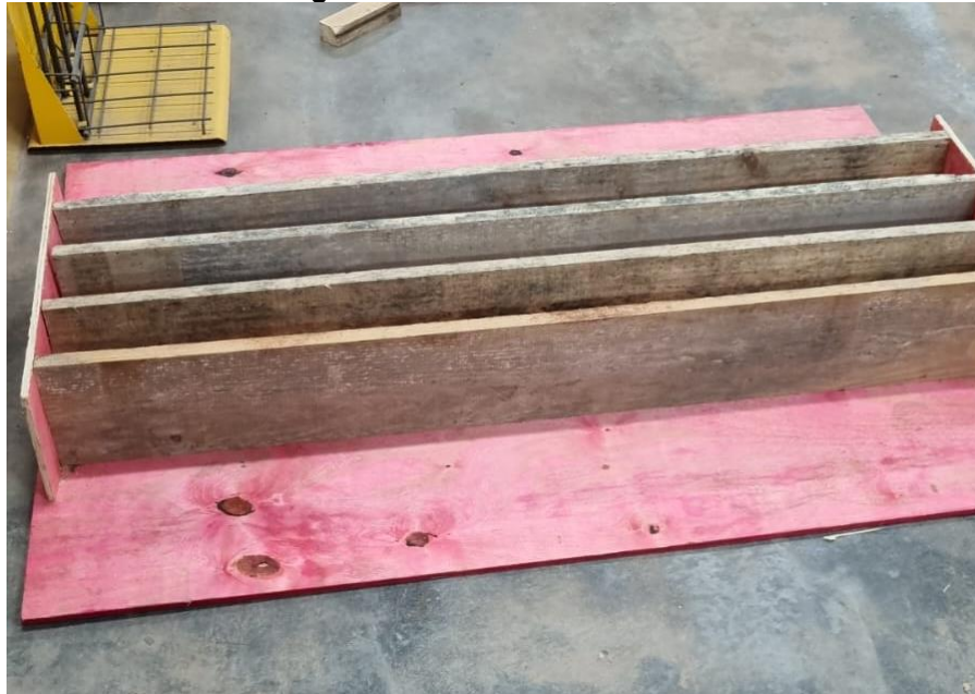
Figura 16 - Fôrmas de madeira
