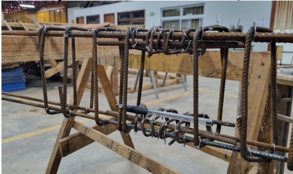
Figura 19 - Detalhe executivo da armadura de reforço
