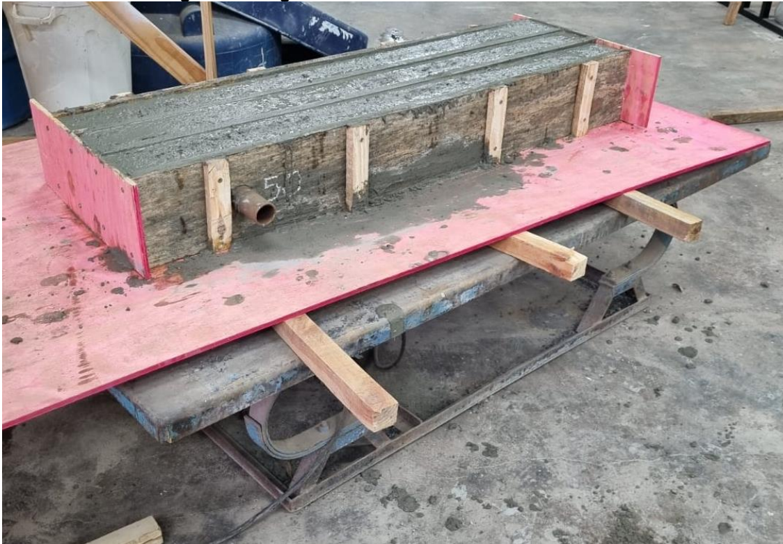
Figura 22 - Vigas concretadas sobre mesa vibratória
