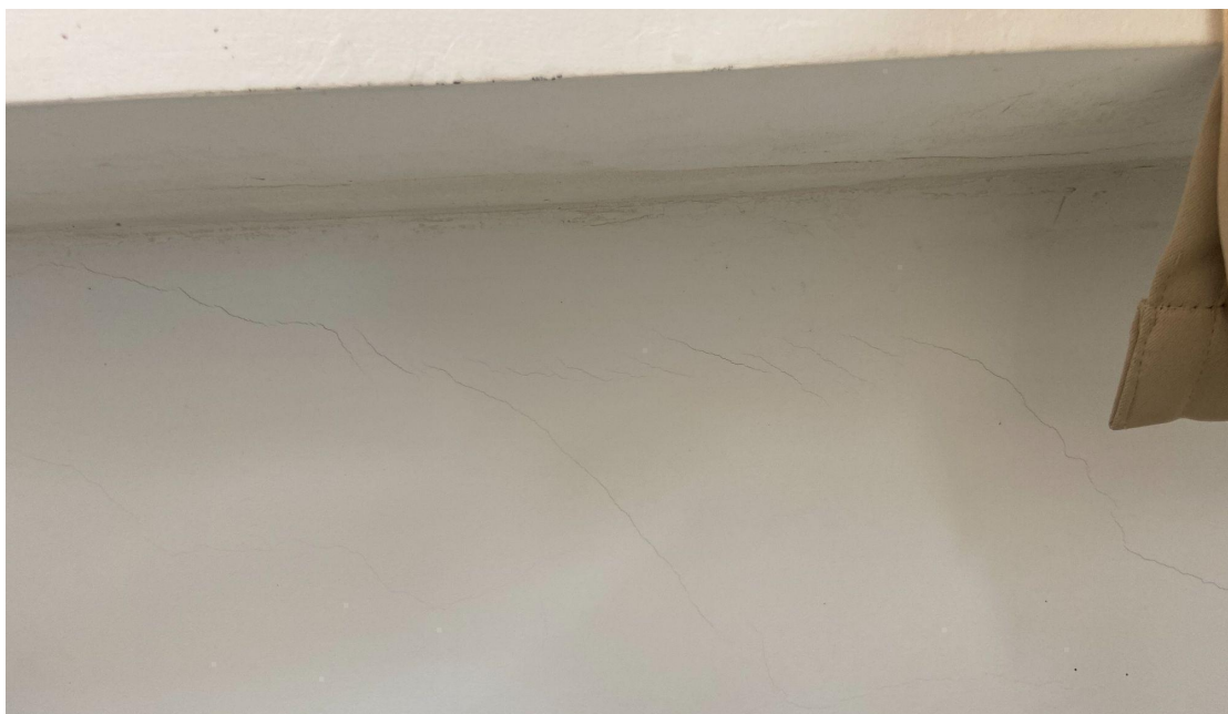
Figura 30 - Fissuras sala 110
