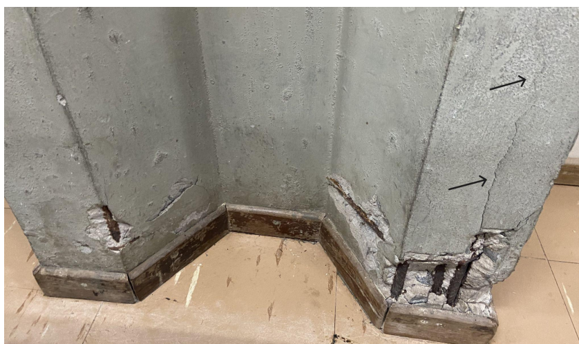
Figura 45 - Fissuras sala 106
