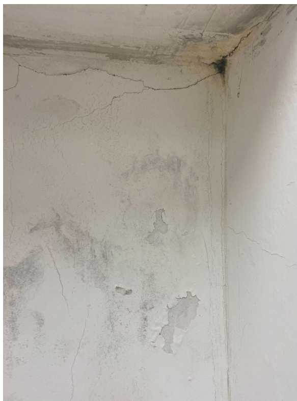
Figura 67 - Descascamentos sala 111
