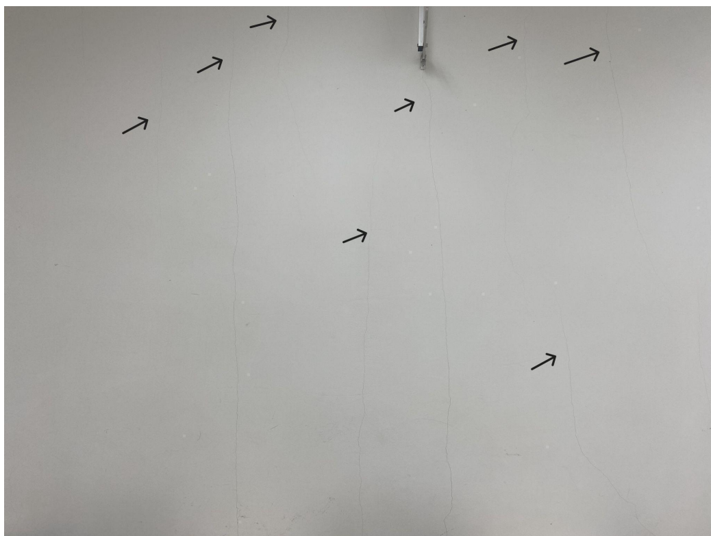
Figura 42 - Fissuras sala 108
