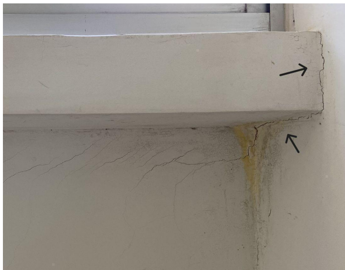
Figura 35 - Fissuras sala 011
