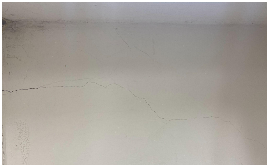
Figura 49 - Fissuras sala 108
