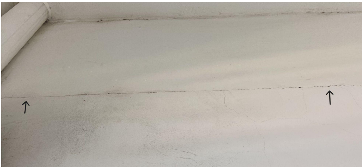
Figura 33 - Fissura sala 107
