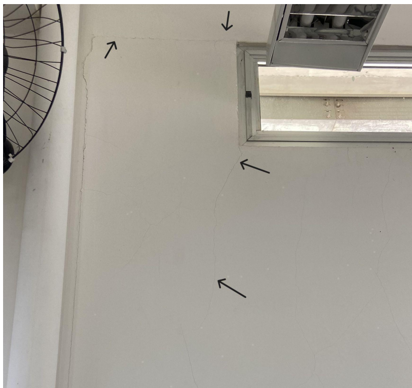
Figura 25 - Fissuras sala 011
