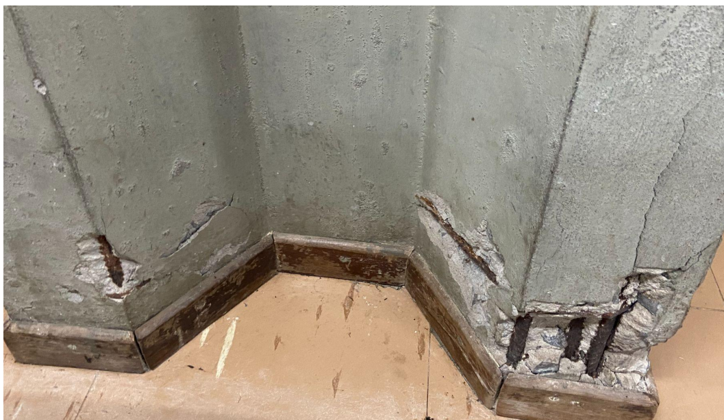
Figura 64 - Desagregação sala 106
