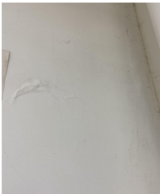
Figura 68 - Bolhas na pintura sala 111
