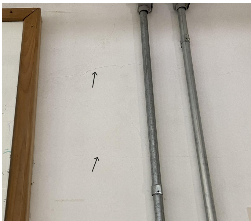
Figura 50 - Fissuras sala 011
