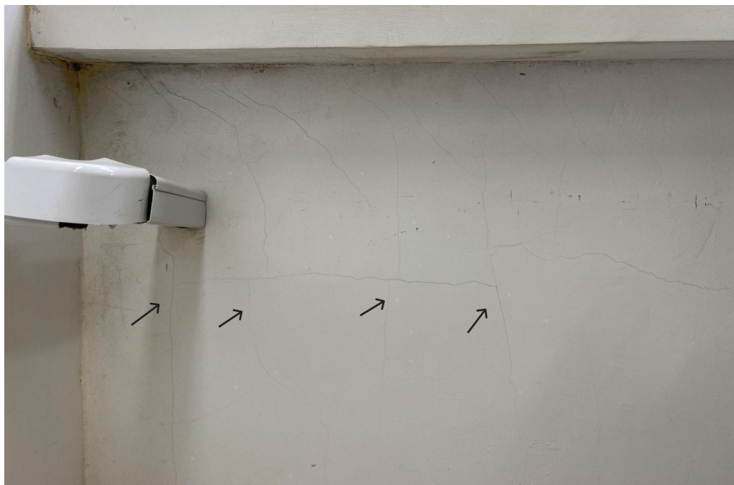
Figura 43 - Fissuras sala 011
