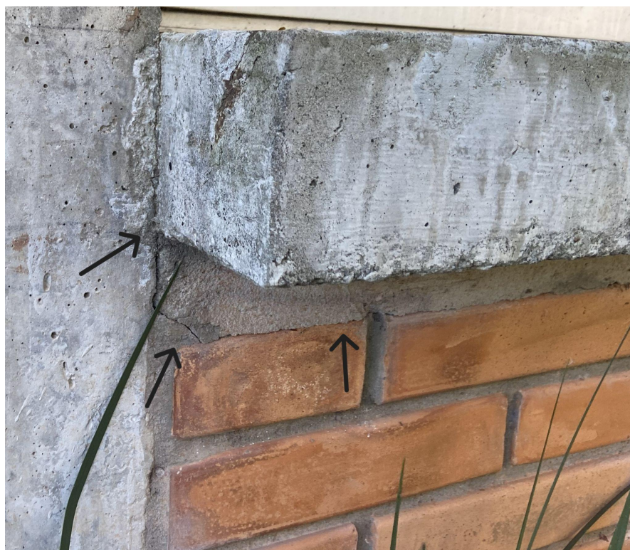
Figura 55 - Fissuras externas
