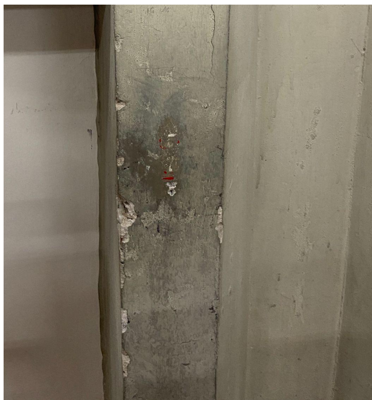
Figura 65 - Desagregação sala 106
