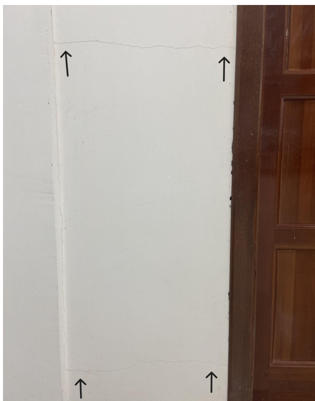
Figura 24 - Fissuras sala 108
