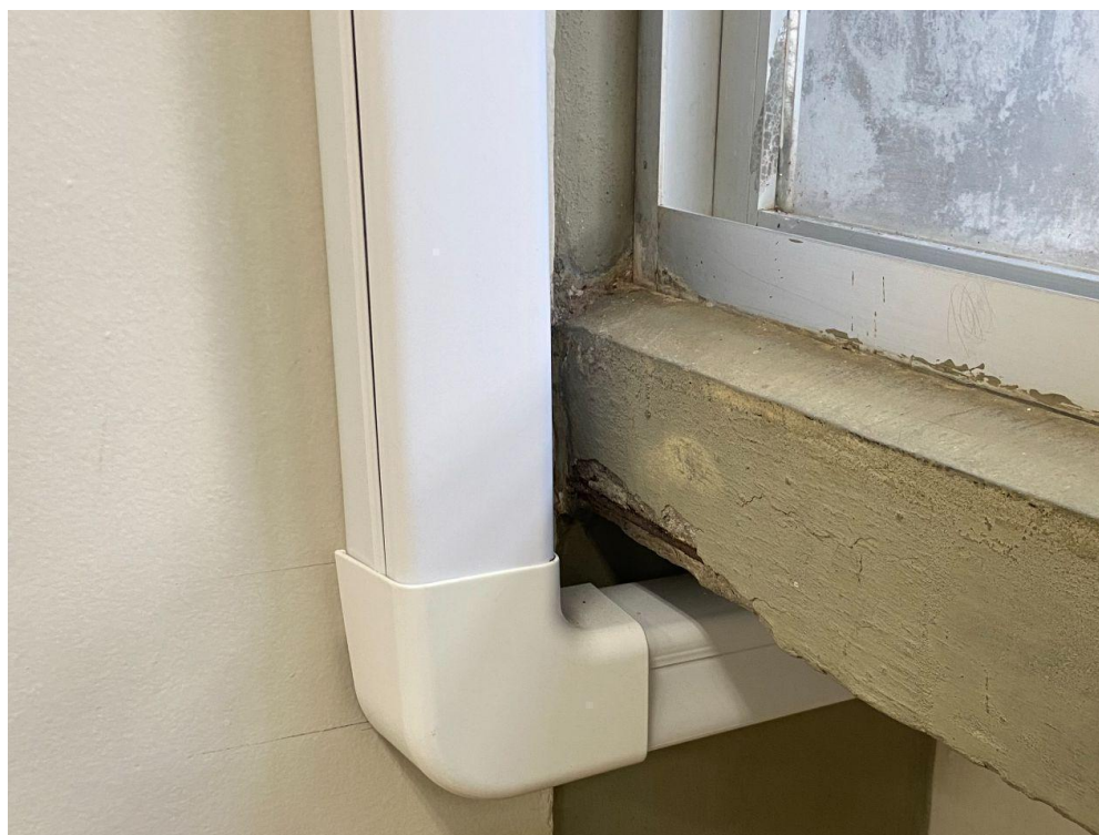
Figura 63 - Desagregação sala 106
