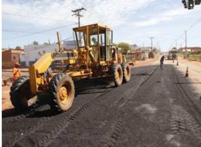
Figura 16 - Execução do pré – misturado a quente
