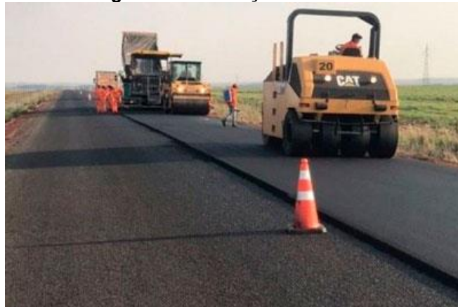
Figura 14 - Execução do CBU Q
