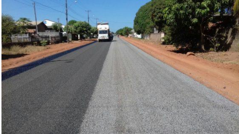
Figura 17 - Execução do Tratamento superficial por penetração direta e invertida
