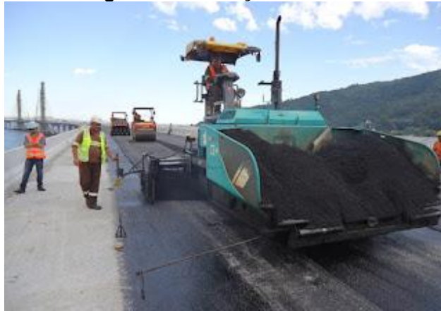
Figura 15 - Execução do CBUQ
