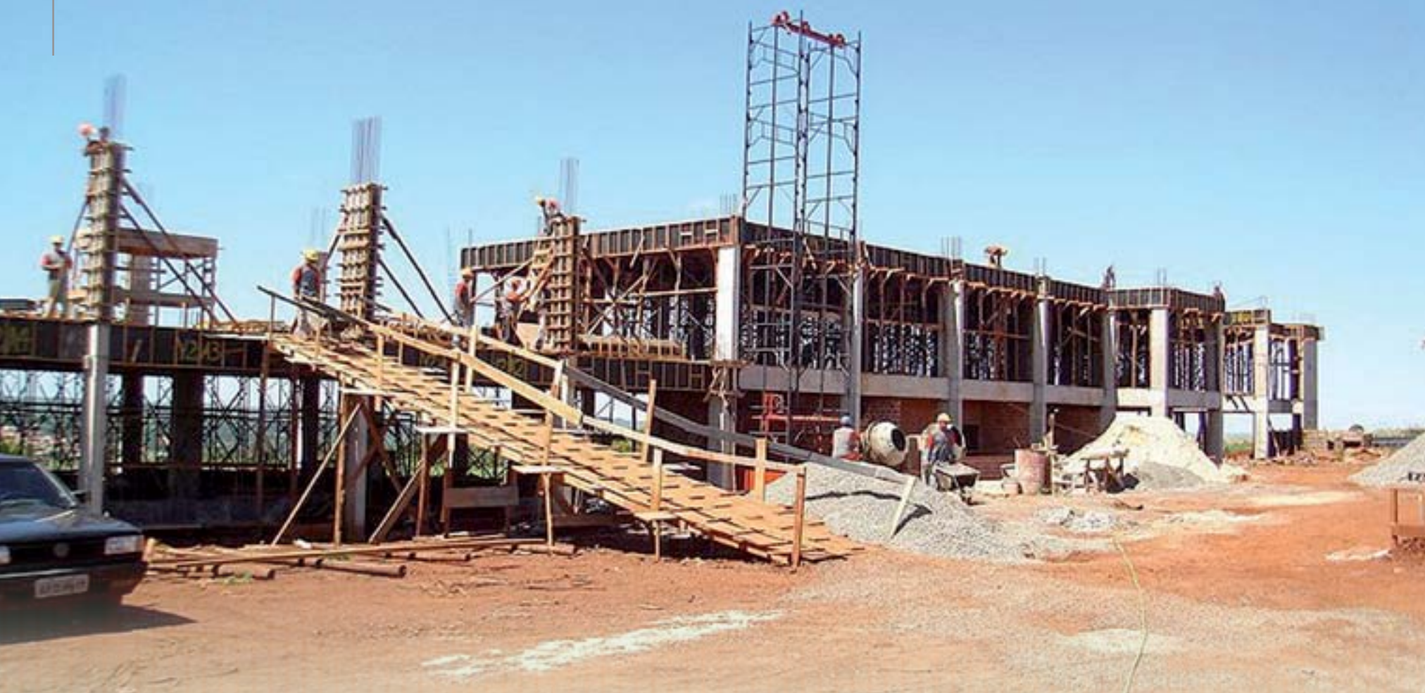
Início das obras do Campus Londrina da UTFPR, em 2007
