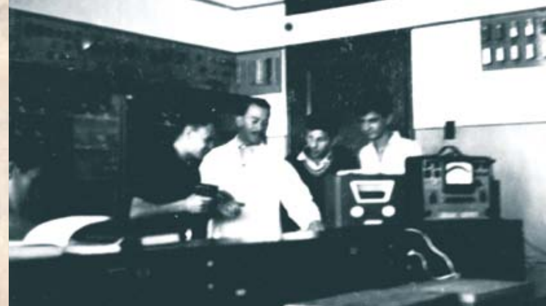
Oficina de Rádio e Eletricidade da Escola Técnica de Curitiba
