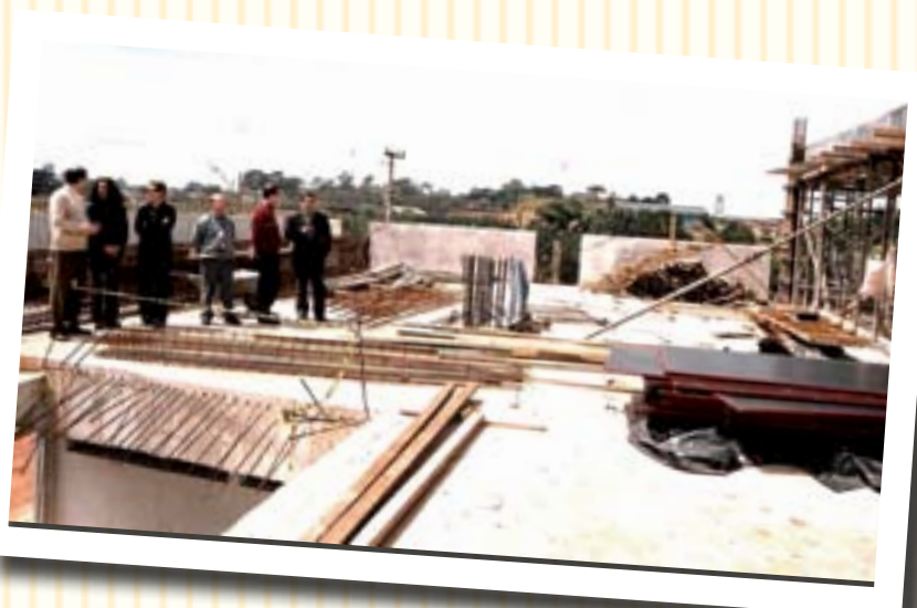
O Diretor do CEFET-PR, professor Eden Januário Netto visita as obras da Unidade. Abaixo, 1º bloco construído e croqui das instalações da Unidade Ecoville (fundo)
