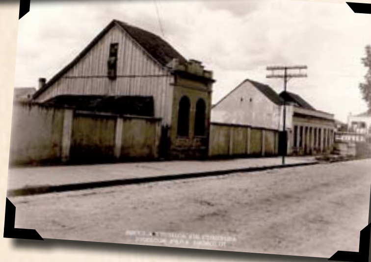
Prédios que seriam desapropriados para ampliação da ETC
