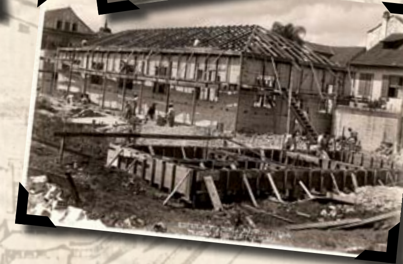
Vinheta da CBAI, croqui do projeto de ampliação da Escola Técnica (fundo) e obras de ampliação
