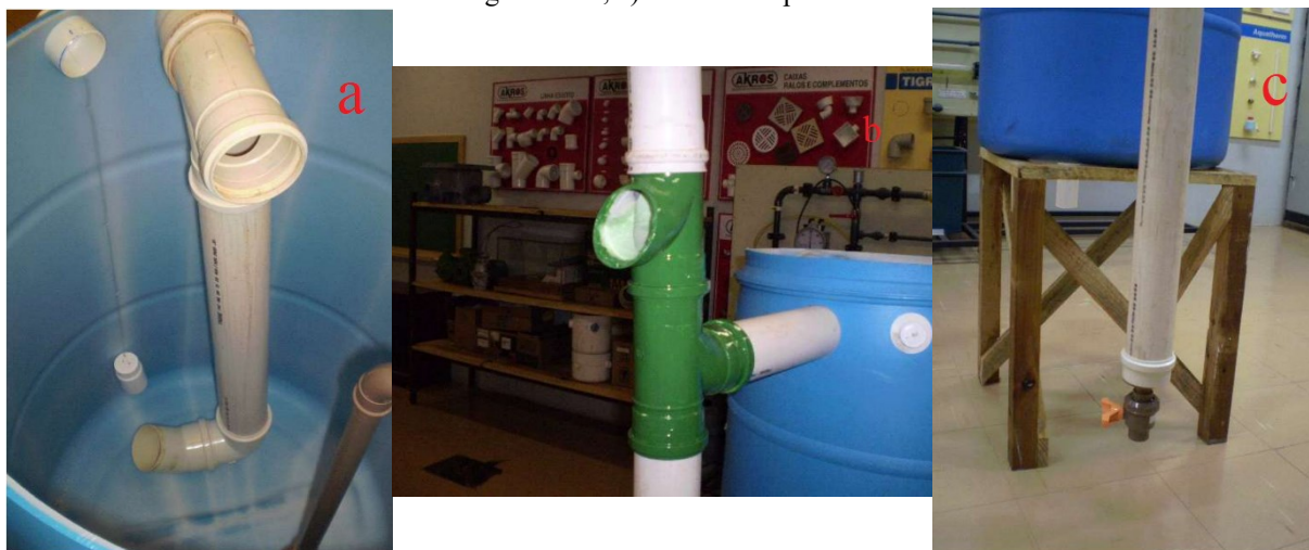
Figura 27 - Dispositivos complementares do sistema de captação e reservação a) redutor de turbulência; b) filtro de sólidos grosseiros; c) descarte da primeira chuva.
