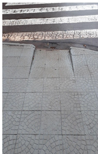
Fotografia 6 - Trecho 1BX: Rampas em não conformes
