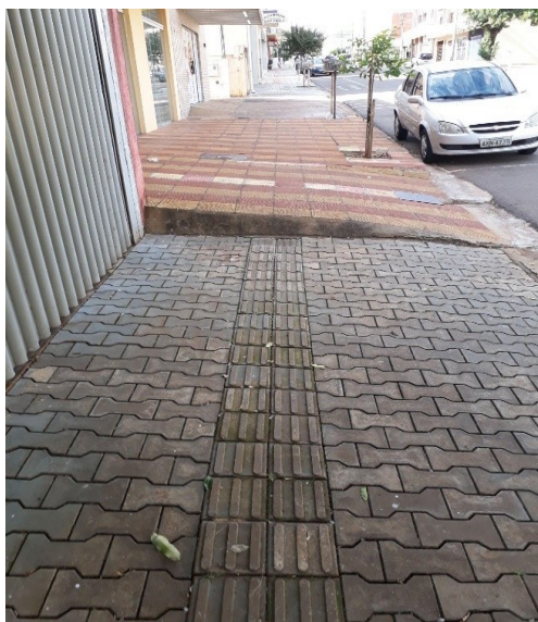
Fotografia 17 - Trecho 2BY Desníveis
