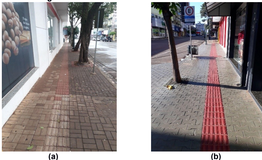
Fotografia 27 - Trecho 4AX: revestimento conforme
