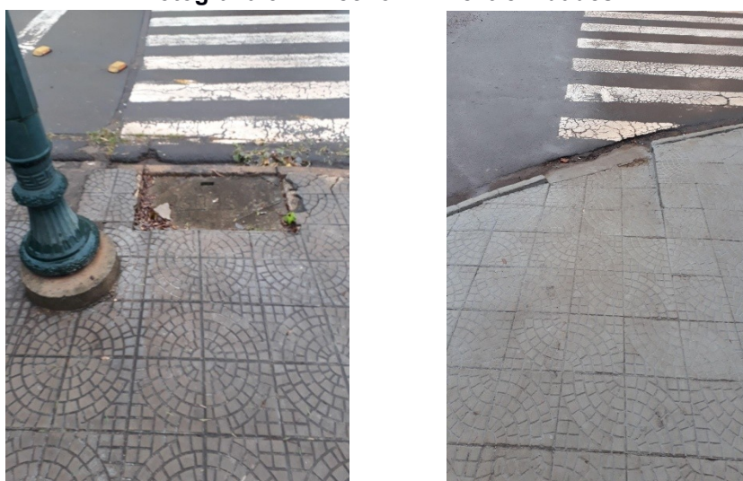
Fotografia 34 - Trecho 4BX: extremidades
