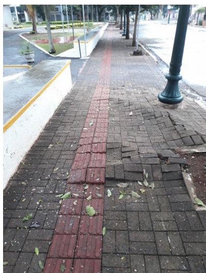
Fotografia 21 - Trecho 3AX: Ressalto e estreitamento
