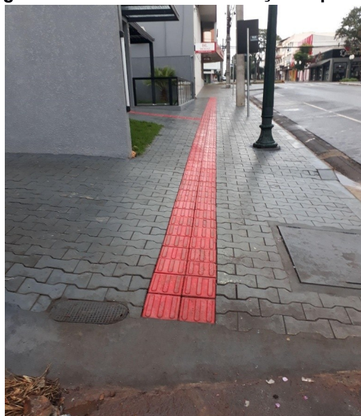
Fotografia 33 - Trecho 4BY: Inclinação superior 2%
