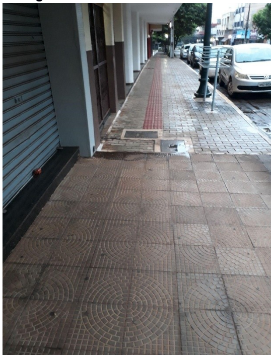
Fotografia 19 - Trecho 3AX: Revestimento
