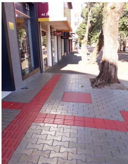
Fotografia 7 - Trecho 1BY : Revestimento em conformidade
