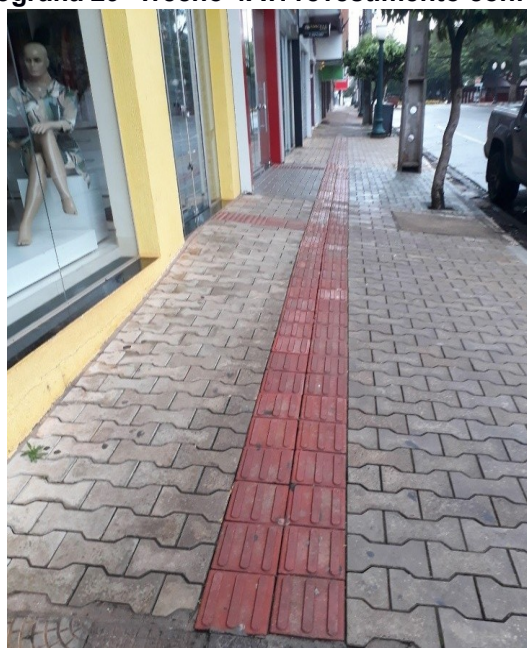
Fotografia 29- Trecho 4AY: revestimento conforme
