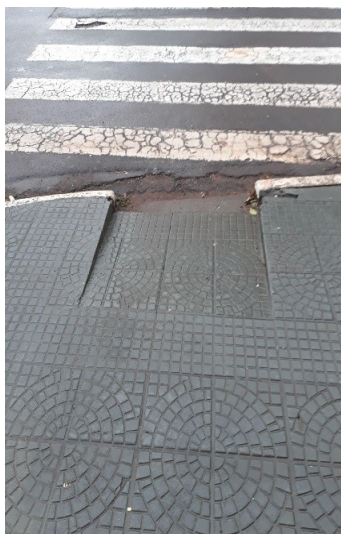
Fotografia 6 - Trecho 1BX: Rampas em não conformes
