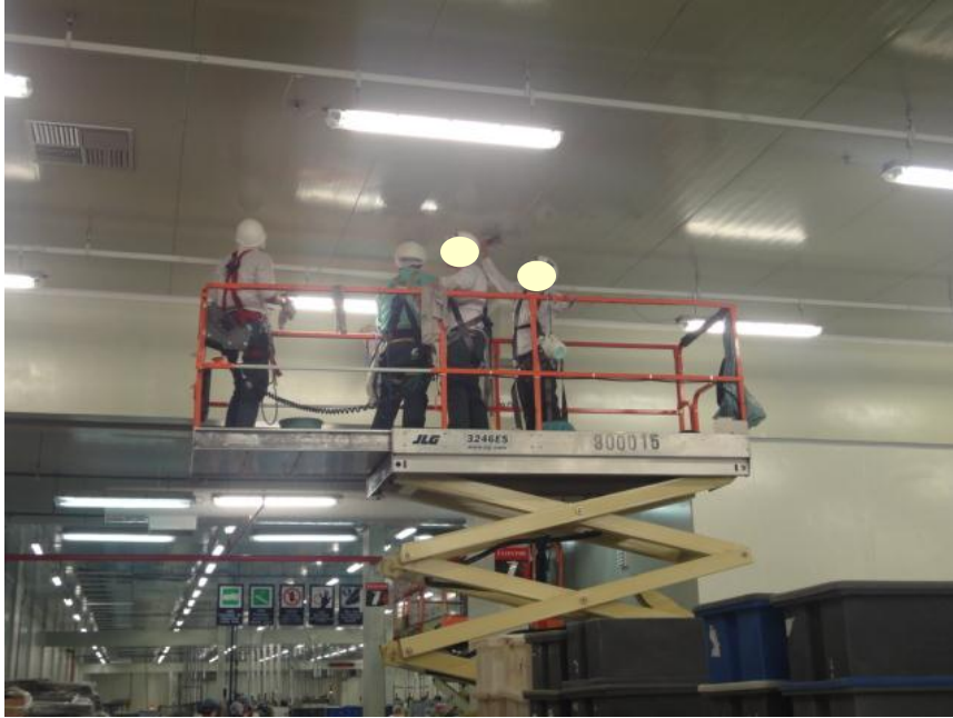
Figura 8: Trabalho de altura para limpeza de forro. Fonte: Autoria própria (2011)
