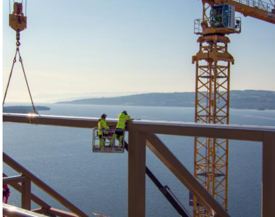
Figura 13 - Uso de elevadores e guindaste de torre
