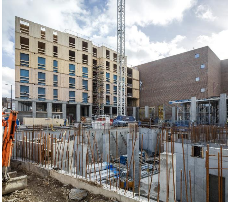
Figura 37 - Estruturas de concreto no piso térreo
