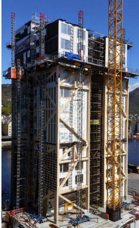
Figura 28 - Uso de andaimes na construção da edificação
