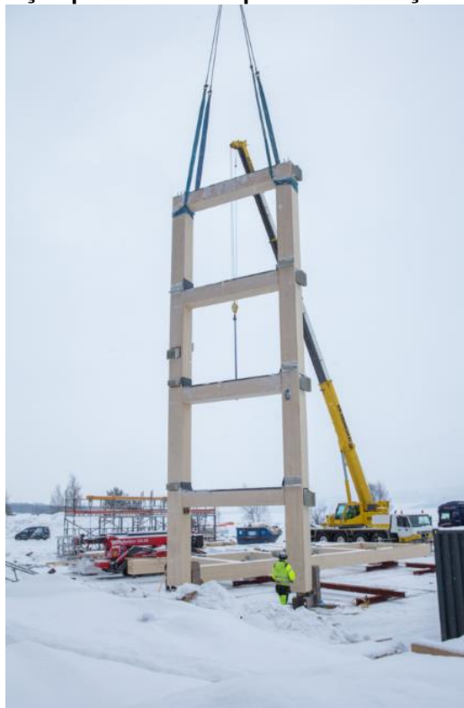
Figura 12 - Peças pré-fabricadas para a construção de Mjøstårnet
