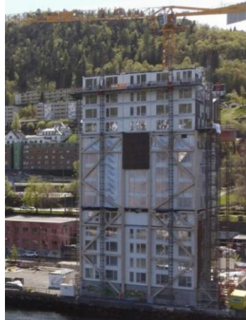
Figura 27 - Uso de guindaste de torre para instalação dos módulos pré-fabricados
