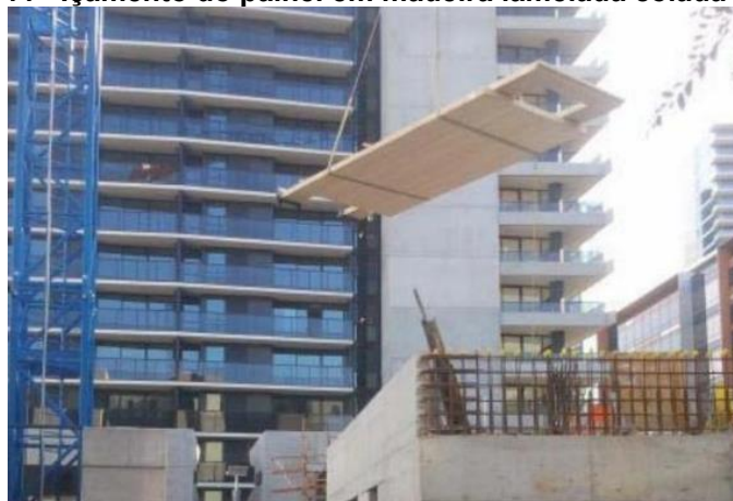
Figura 44 - Içamento do painel em madeira lamelada colada cruzada
