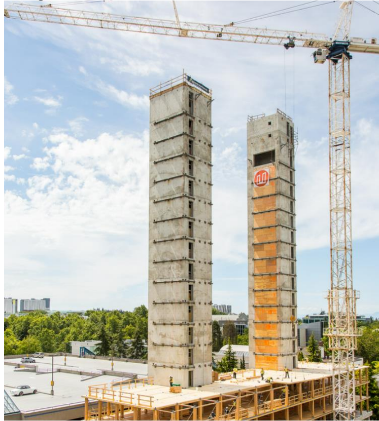
Figura 17 - Núcleo de concreto no edifício Tall Wood
