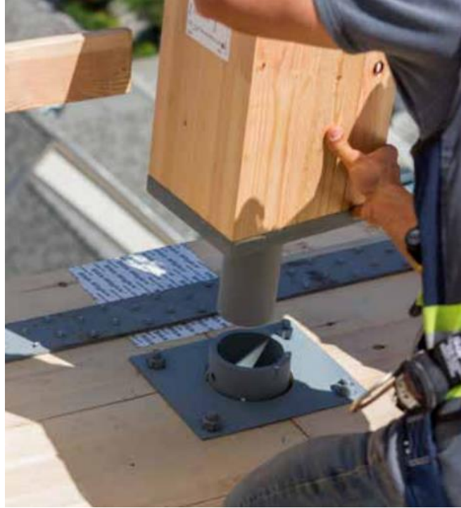
Figura 22 - Instalação da coluna no piso em madeira
