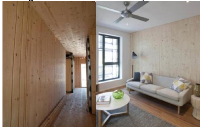
Figura 41 - Detalhes da edificação interna
