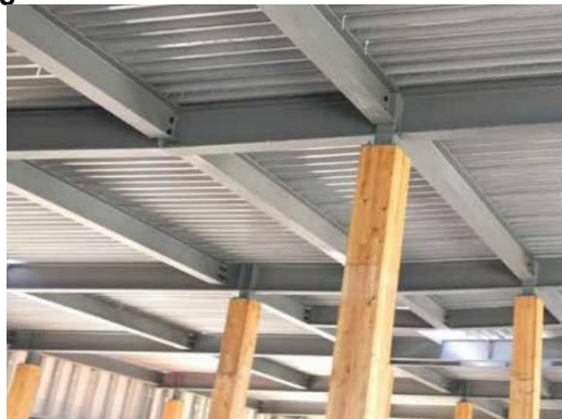
Figura 16 - Estrutura do telhado em Tall Wood
