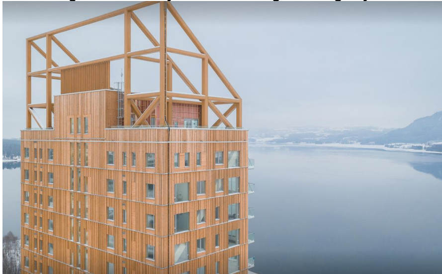
Figura 7 - Torre Mjøstårnet na margem do lago Mjøsa
