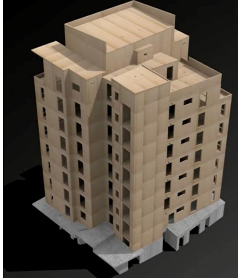
Figura 40 - Estrutura em MLCC e concreto do edifício Forté
