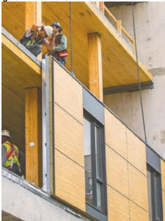
Figura 19 - Painel externo do edifício Tall Wood
