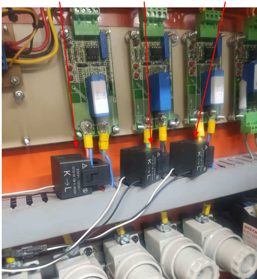
Figura 20 – Posicionamento dos TCs para a medição das correntes de linha.
