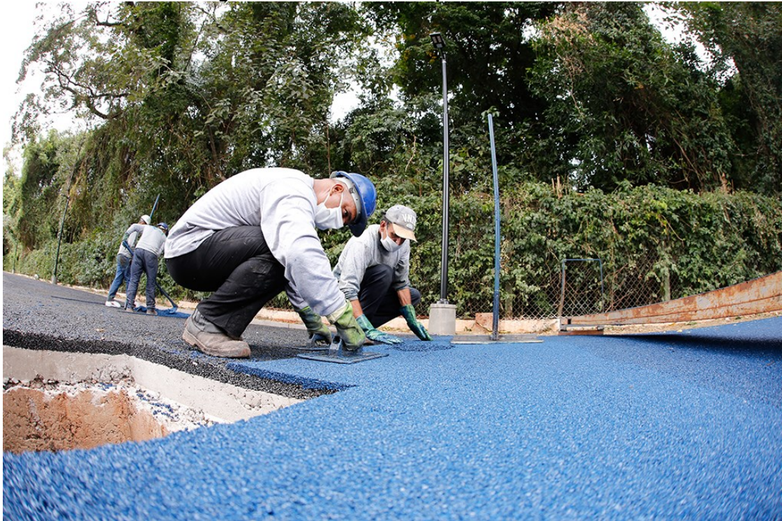
Fotografia 18 – Camadas da pista de caminhada
