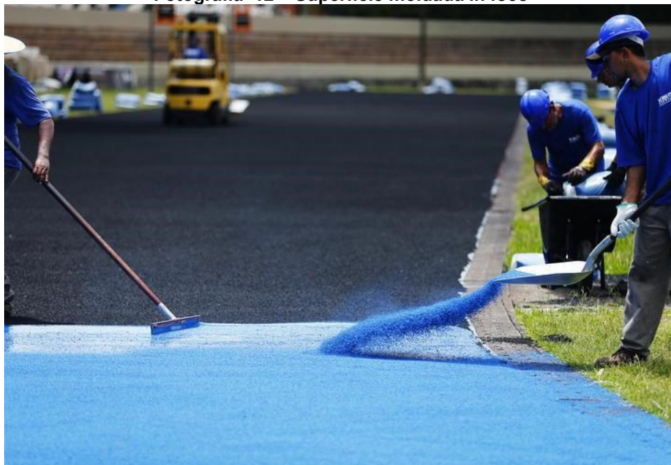
Fotografia 12 – Superfície moldada in loco
