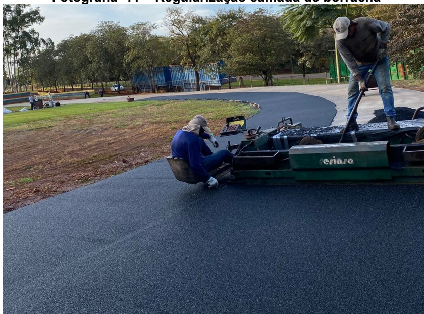
Fotografia 11 – Regularização camada de borracha
