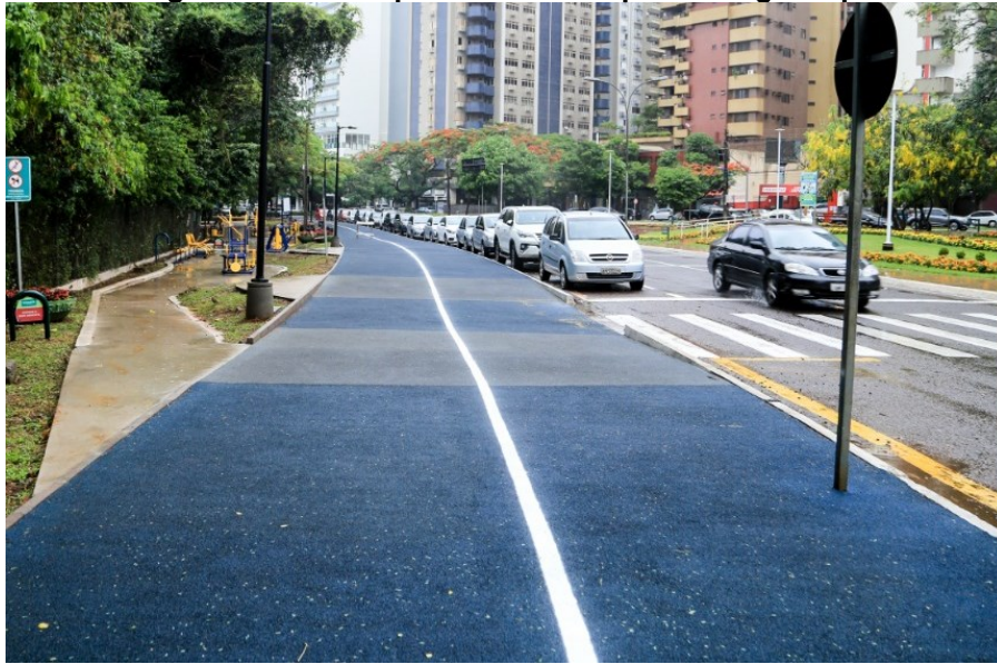
Fotografia 19 – Rampas de acesso após entrega da pista
