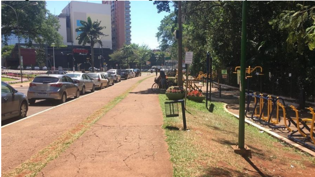
Fotografia 13 - Pista do Parque do Ingá antes da aplicação do piso de borracha
