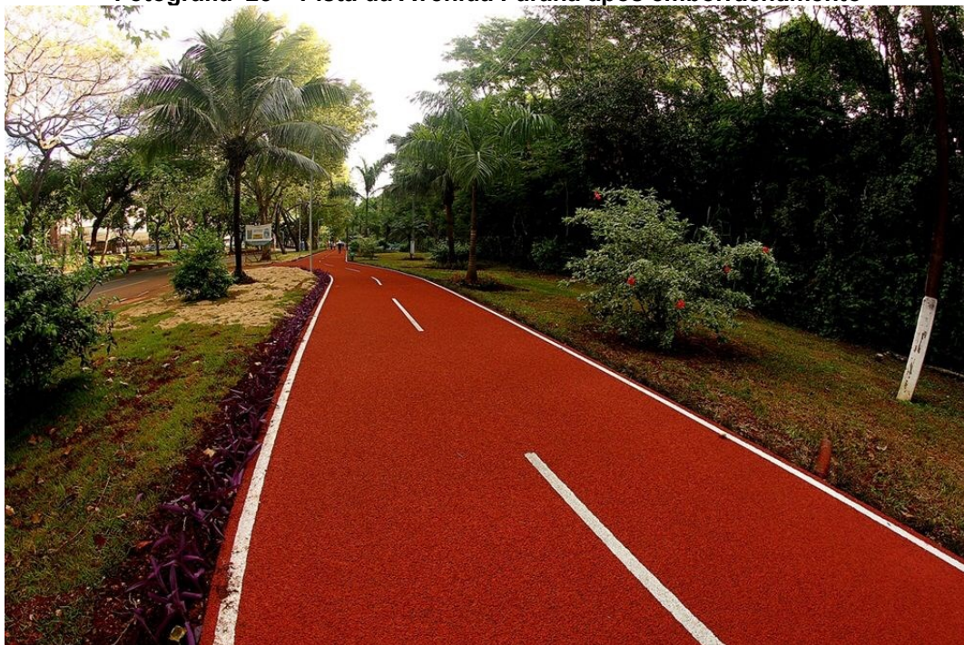
Fotografia 25 – Pista da Avenida Paraná após emborrachamento
