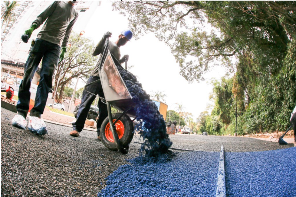
Fotografia 14 - Aplicação da pista emborrachada
