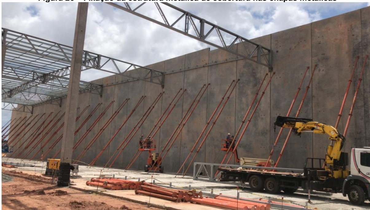
Figura 26 – Fixação da estrutura metálica de cobertura nas chapas metálicas
