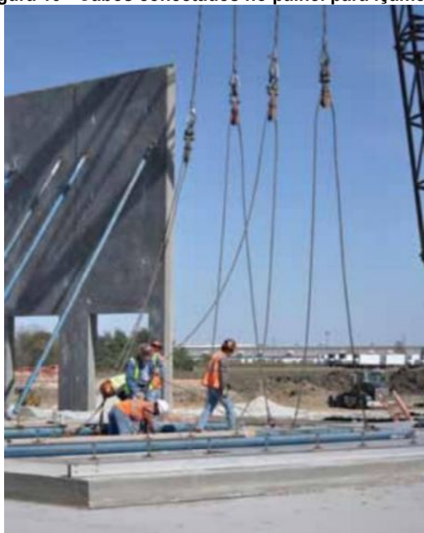
Figura 10 - Cabos conectados no painel para içamento
