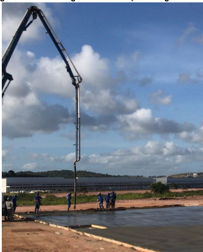
Figura 15 – Concretagem com utilização da régua vibratória
