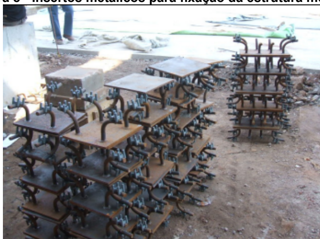
Figura 8 - Insertos metálicos para fixação da estrutura metálica
