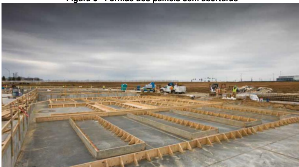
Figura 5 - Fôrmas dos painéis com aberturas
