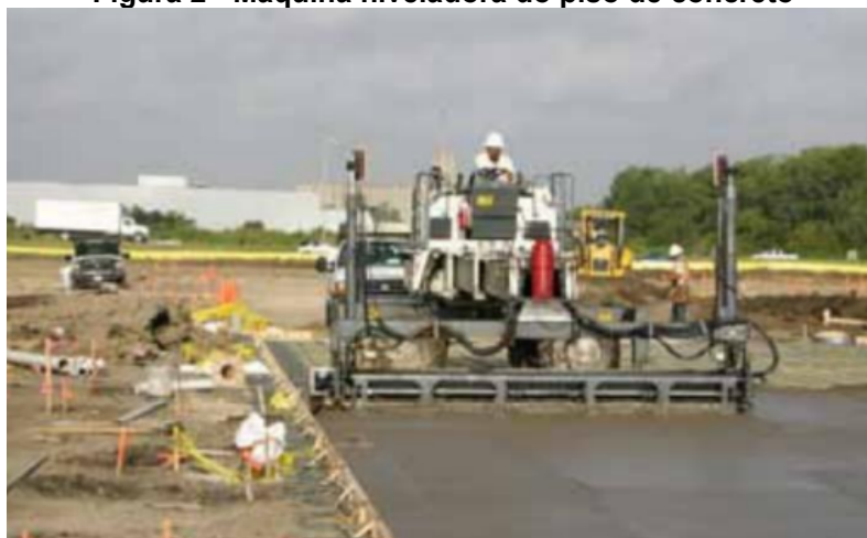
Figura 2 - Máquina niveladora do piso de concreto
