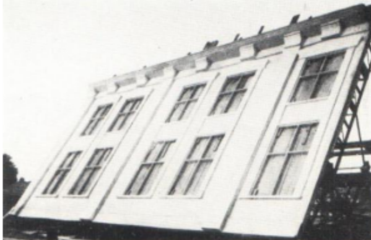
Figura 1 - Uma parede sendo levantada para refeitório de Camp Perry
