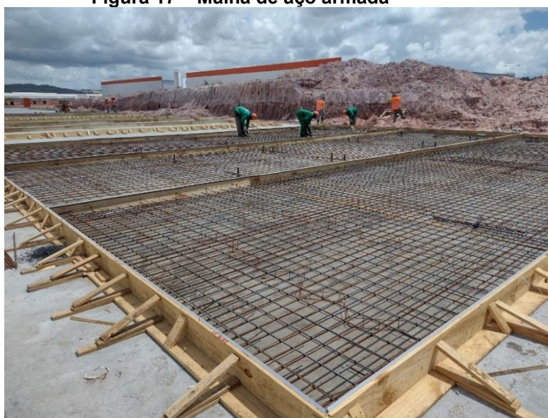
Figura 17 – Malha de aço armada
