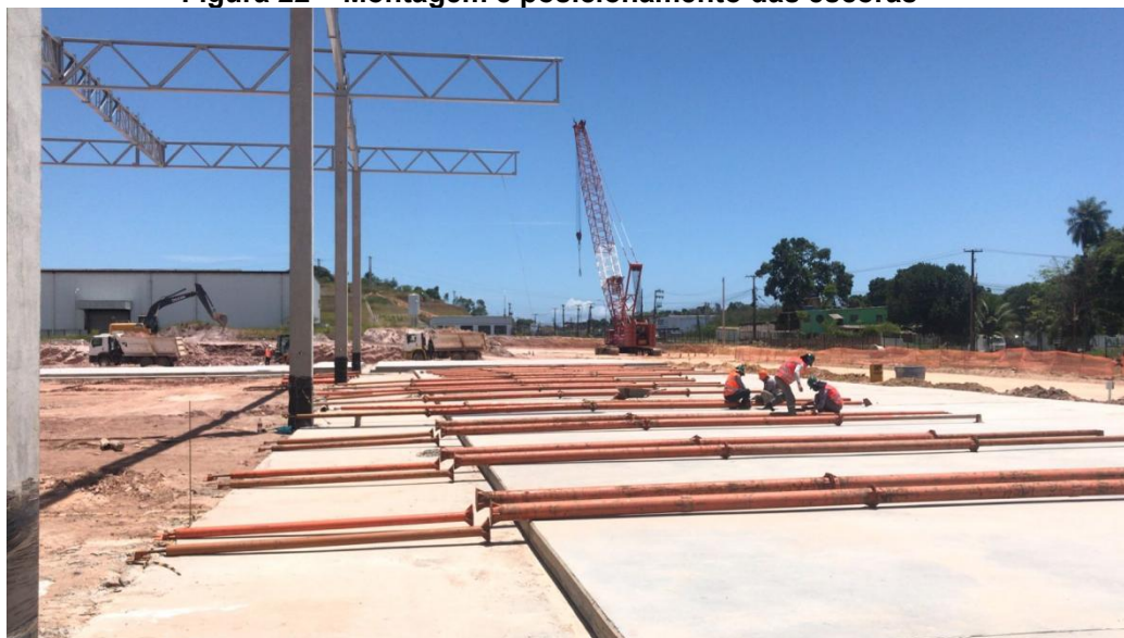
Figura 22 – Montagem e posicionamento das escoras
