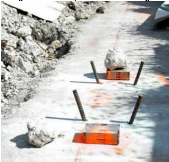
Figura 3 - Fundação com hastes de guia
