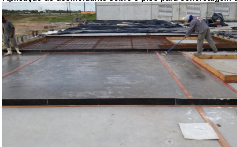
Figura 7 - Aplicação de desmoldante sobre o piso para concretagem dos painéis
