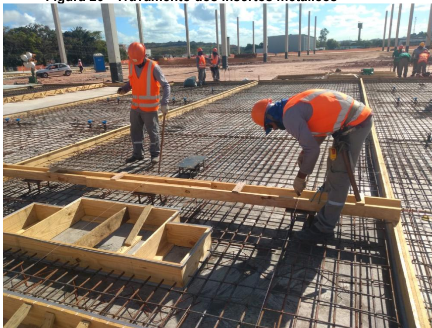
Figura 20 - Travamento dos insertos metálicos
