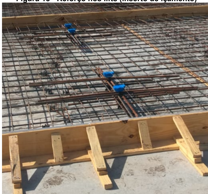
Figura 18 - Reforço nos lifts (inserto de içamento)
