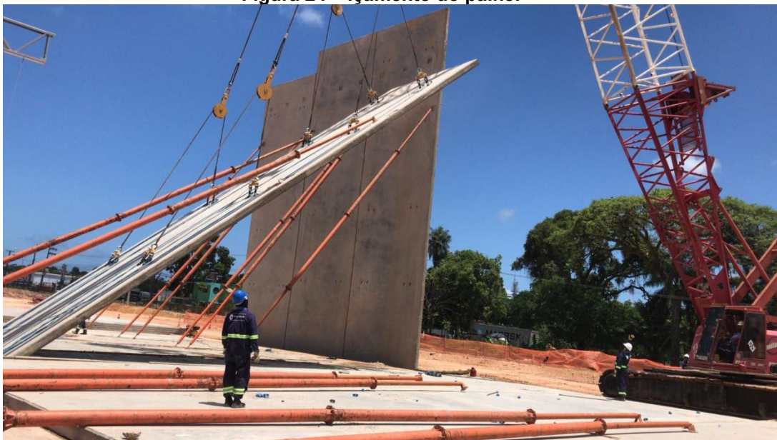
Figura 24 – içamento do painel
