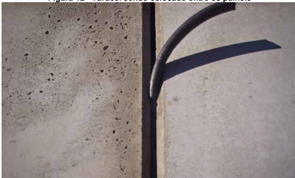
Figura 12 - Tarucel sendo colocado entre os painéis
