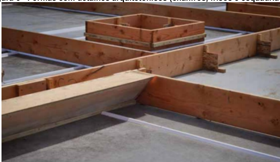
Figura 6 - Fôrmas com detalhes arquitetônicos (chanfros, frisos e esquadria 45°)
