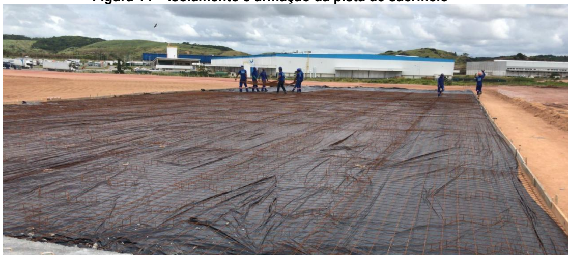
Figura 14 – Isolamento e armação da pista de sacrifício
