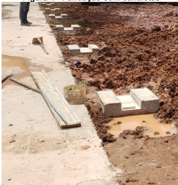
Figura 4 - Fundação com canaletas
