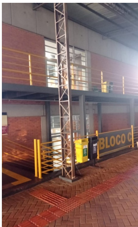
Figura 17 – Fachada Bloco C
