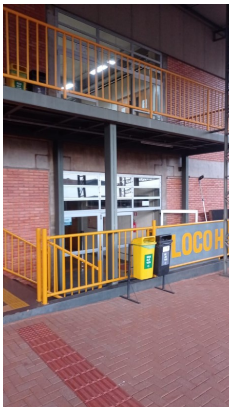
Figura 41 – Fachada Bloco H
