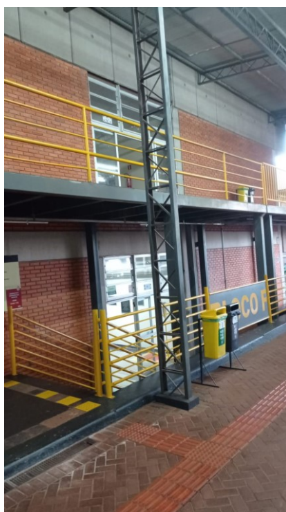
Figura 31 – Fachada Bloco F
