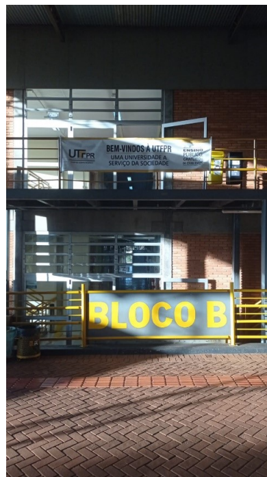
Figura 11 – Fachada Bloco B
