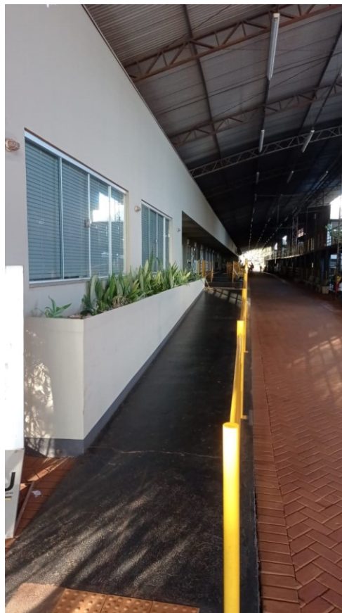
Figura 6 – Fachada Bloco A
