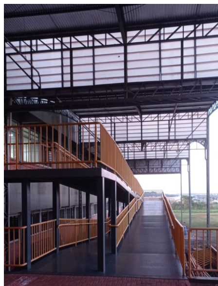
Figura 39 – Rampa de acesso ao Bloco G. Fonte: Autoria Própria (2023)
