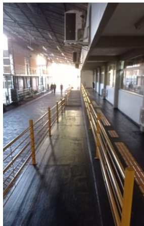
Figura 10 – Rampa de acesso ao Bloco A
