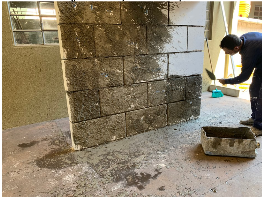
Figura 16 – Lançamento do chapisco.
