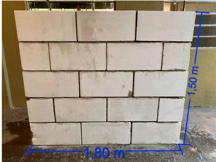
Figura 14 – Parede de substrato finalizada.
