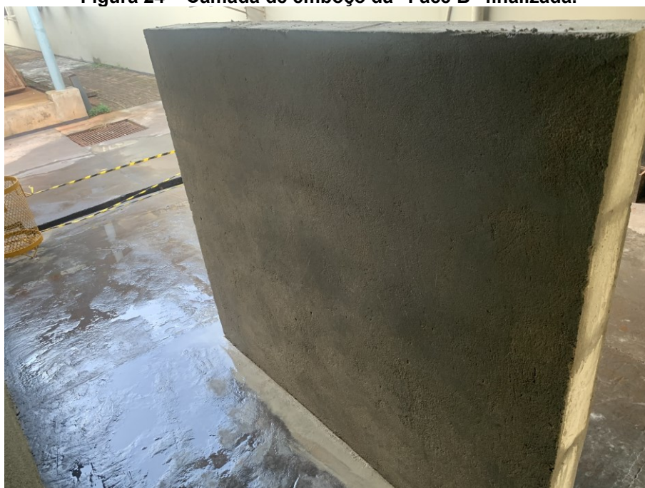
Figura 24 – Camada de emboço da “Face B” finalizada.
