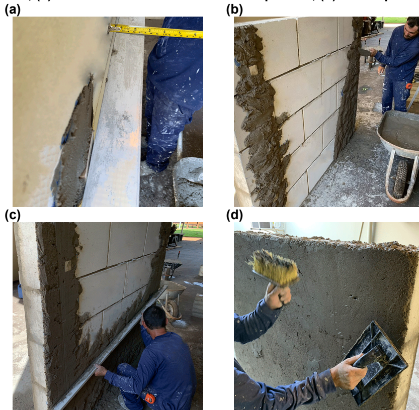
Figura 23 – Camada de emboço “Face B”: (a) Gabarito da espessura, (b) Enchimento das mestras, (c) Enchimento e nivelamento da superfície, (d) Desempenamento.
