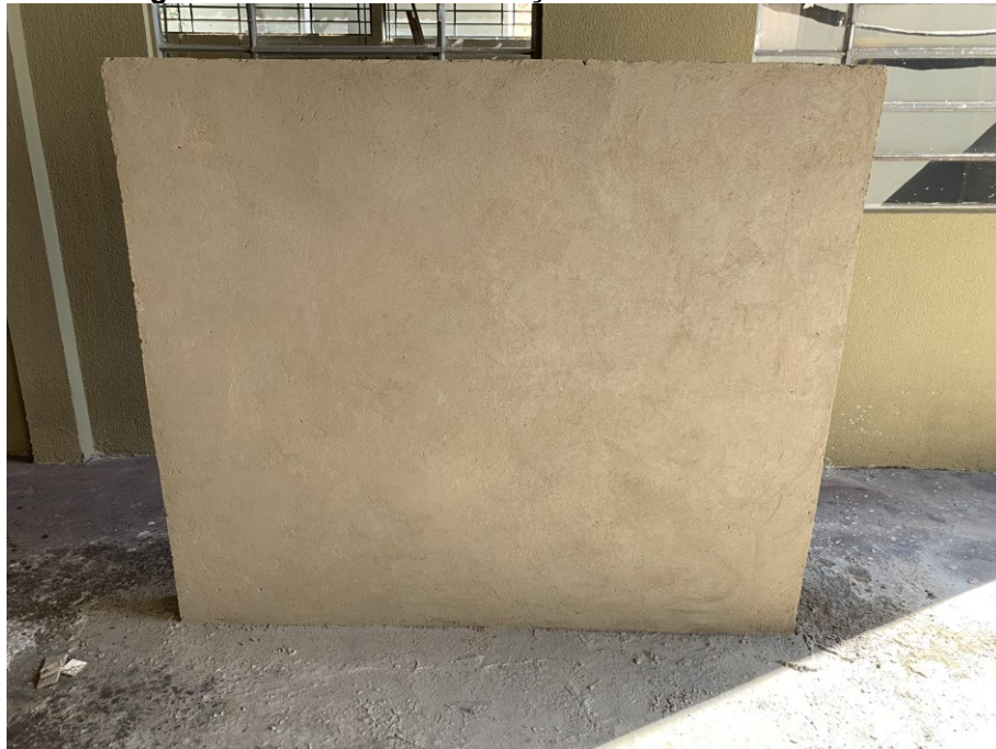
Figura 22 – Camada de emboço da “Face A” finalizada.
