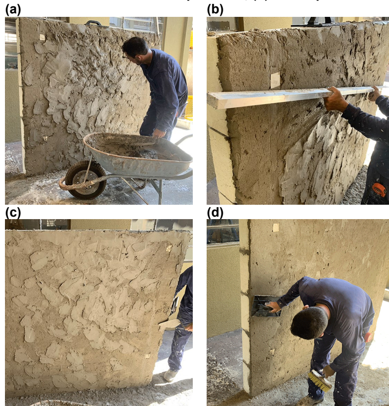
Figura 21 – Camada de emboço “Face A”: (a) Enchimento, (b) Regularização, (c) Preenchimento de vazios superficiais, (d) Desempenamento.
