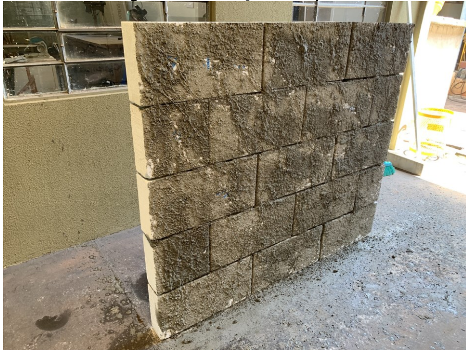
Figura 17 – Finalização do chapisco.
