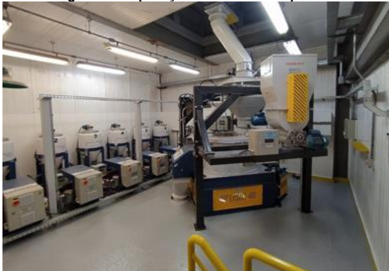
Figura 24 – Aplicação do tratamento químico.
