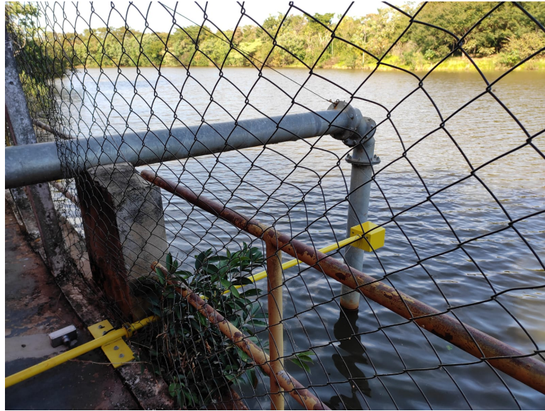
Figura 33 – Instalação do sensor de nível.
