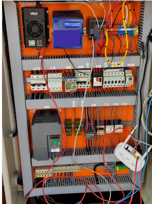
Figura 28 – Quadro geral da sede.
