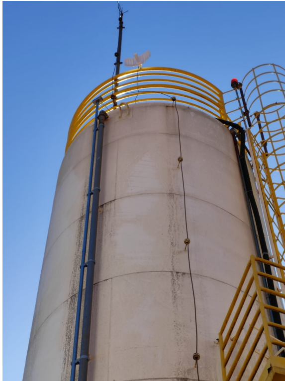
Figura 32 – Instalação da antena da sede.
