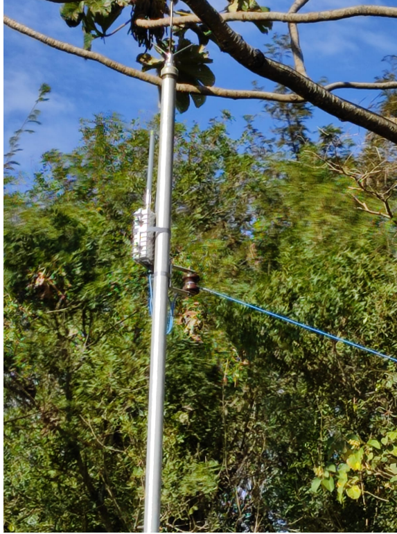
Figura 31 – Instalação de antenas nas lagoas.
