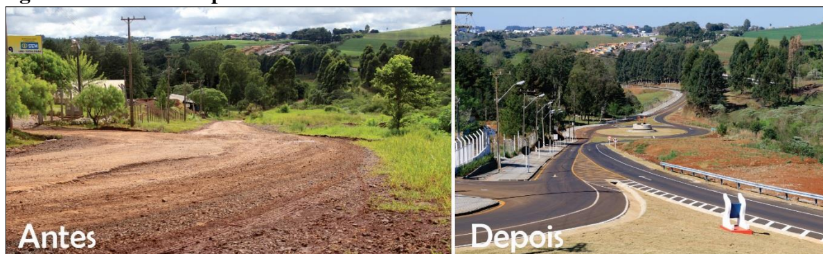
Figura 32 – Antes e depois da Rua Ivaí – acesso à PR 158
