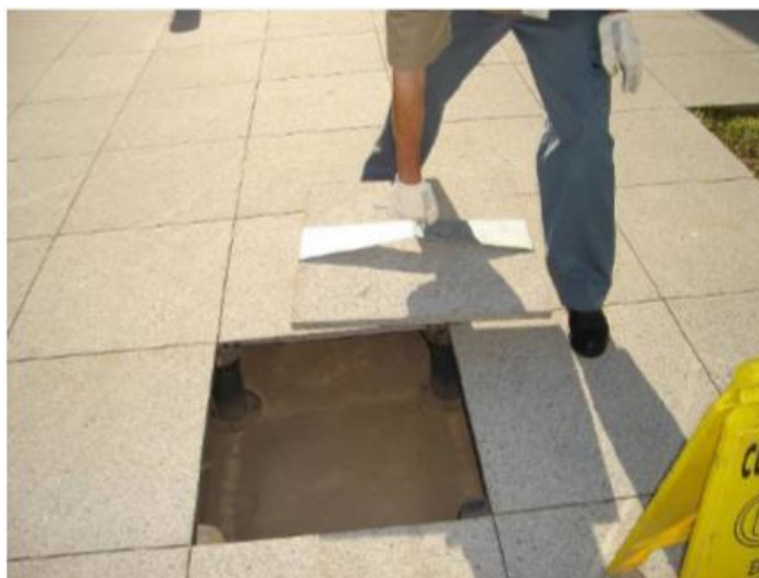
Figura 2 – Aplicação de compósitos cimentícios laminados em piso elevado Fonte: Bernardes (2009)
