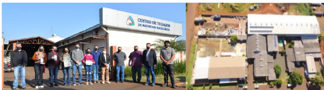
Figura 3 - Central de triagem de Santa Terezinha do Itaipu
