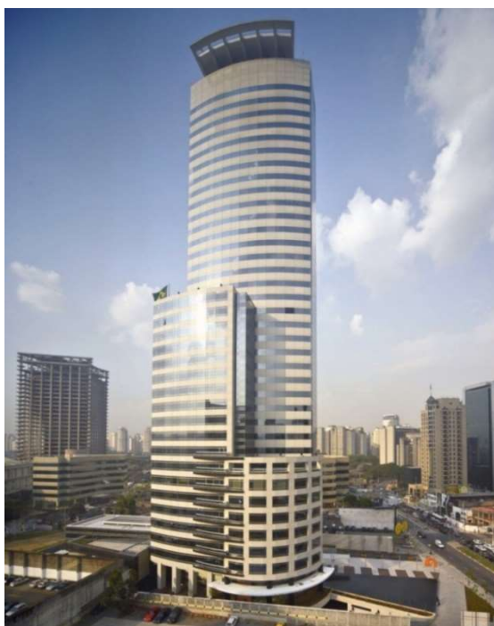
Figura 5 – Edifício E-tower – São Paulo (2002). Fonte: NELSON KON.
