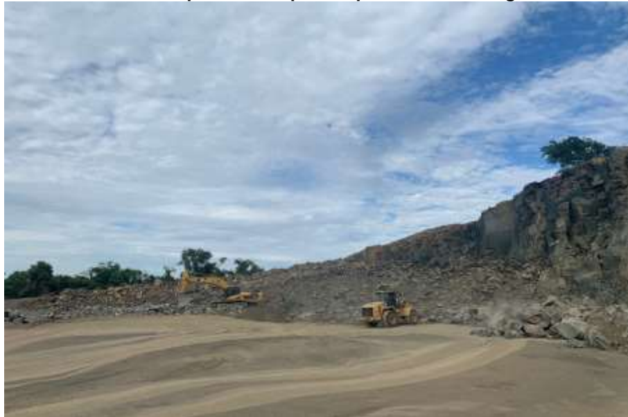
Figura 14. Escavadeira separando as pedras para serem carregadas no caminhão
