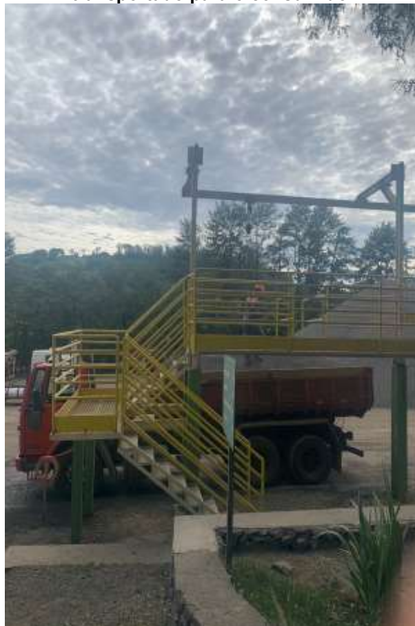
Figura 26. Carroceria do caminhão carregado sendo tapado com lona antes de ser pesado e transportado para o consumidor
