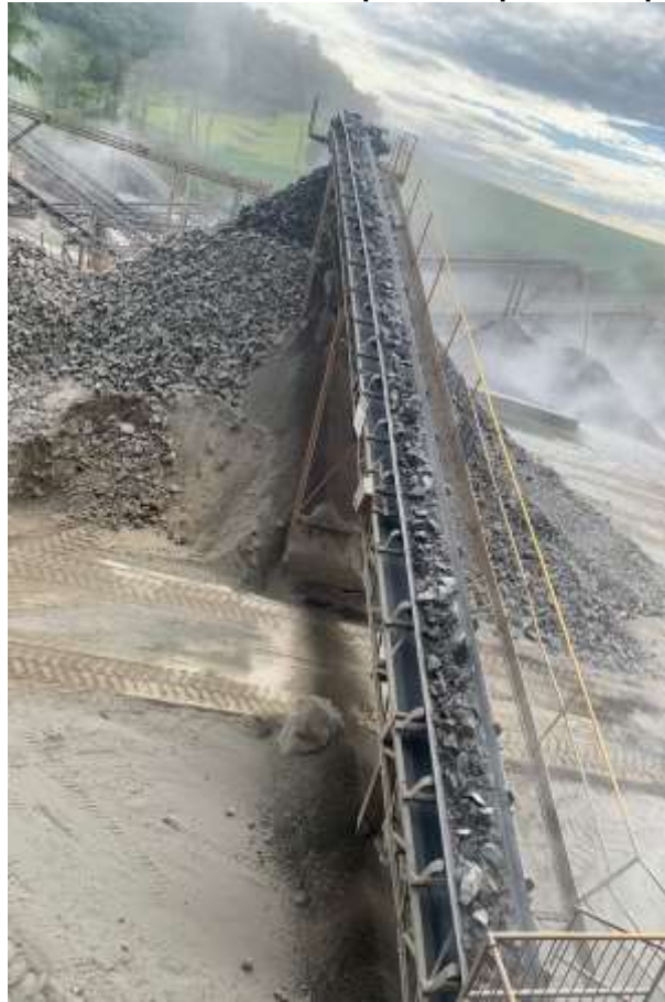
Figura 21. Pedra rachão saindo da peneira e passando pela esteira
