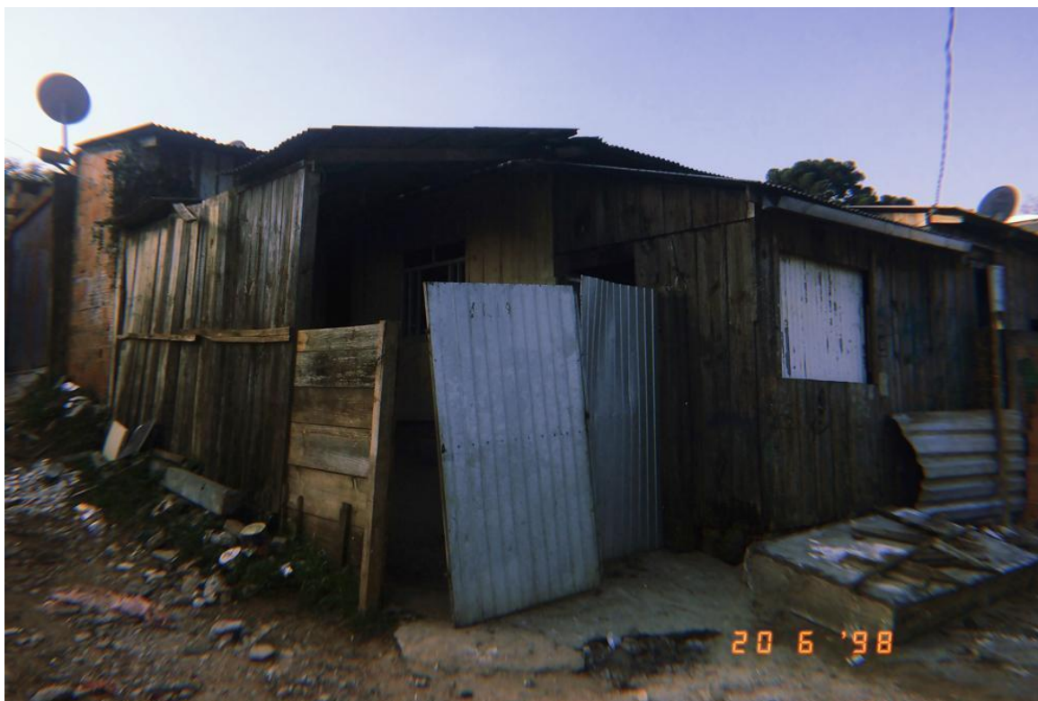
Fotografia 3 - Sede do MOB-PR (antes de sua reforma)
