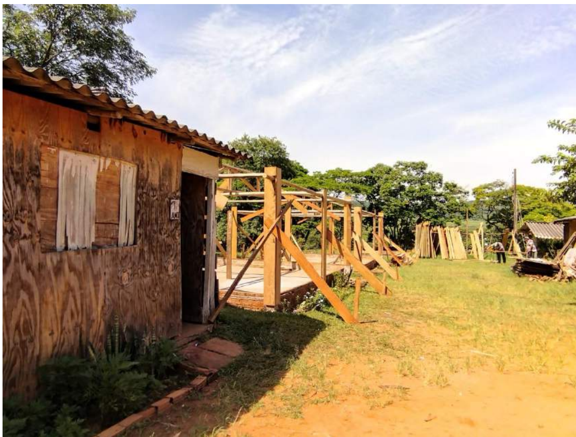
Figura 33: Fotografia da construção da Escola Itinerante Valmir Motta de Oliveira
