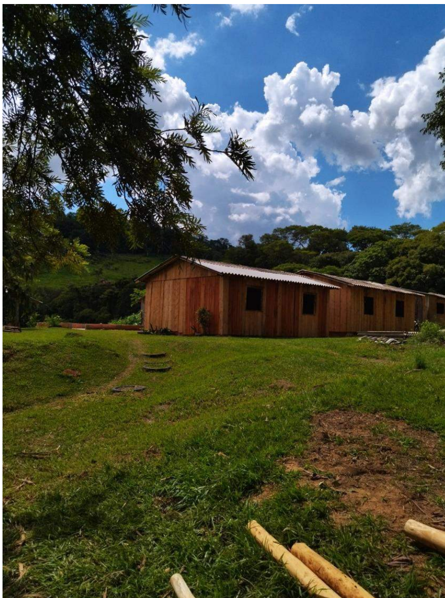
Figura 13: Fotografia da estrutura física da Escola Itinerante Valmir Motta de Oliveira.
