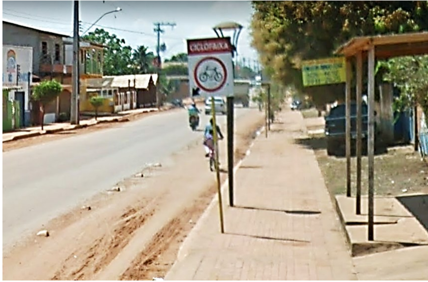
Figuras 30, 31 e 32 Rio Branco – AC. Infraestruturas ciclovias com problemas
