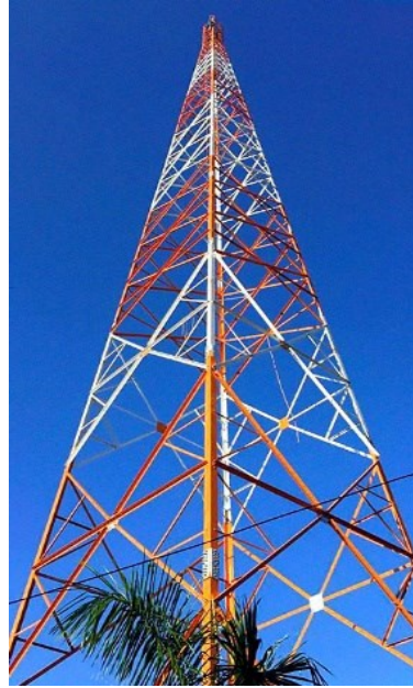
Figura 1 - Torre Autoportante de aço
