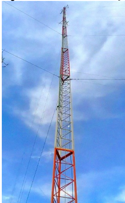
Figura 2 - Torre Estaiada de aço
