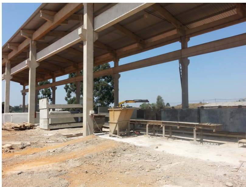
Figura 2 - Características construtivas da fábrica
