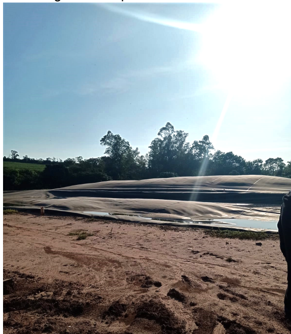
Figura 8. Biodigestor do tipo Canadense na Alimentos do Zé.
