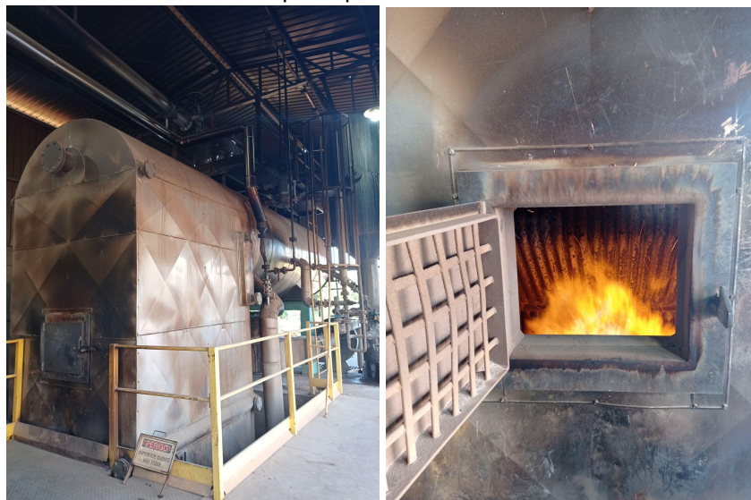
Figura 9. Caldeira industrial utilizada para queima de combustível na Alimentos do Zé.
