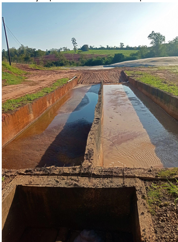
Figura 7. Tanques de sedimentação para o tratamento da manipueira na Alimentos do Zé.
