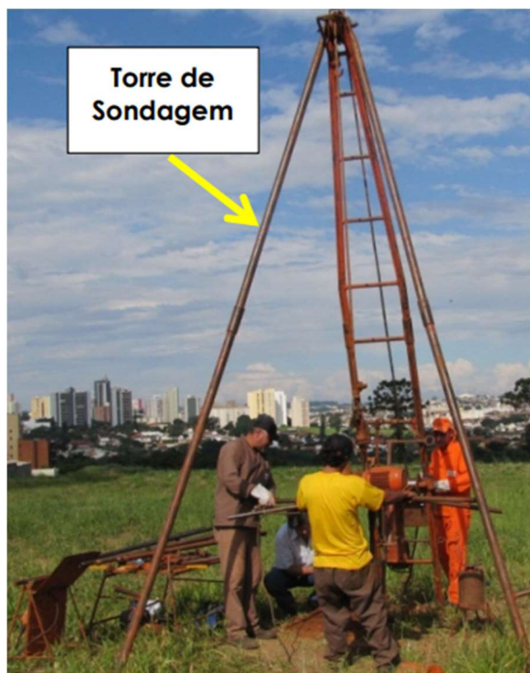
Figura 2 - Torre de sondagem completa SPT
