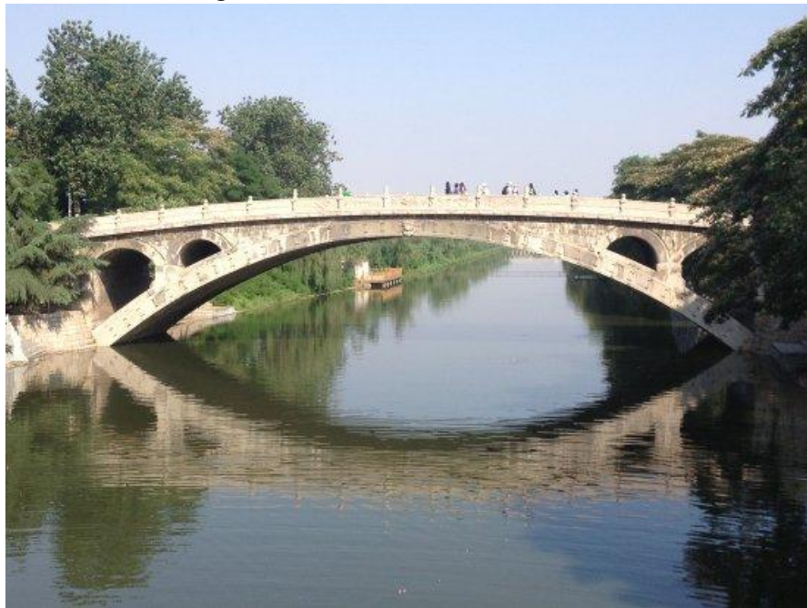
Figura 15 - Ponte Zhaozhou, na China
