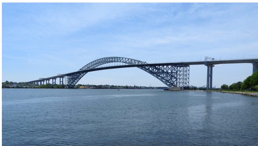
Figura 30 - Ponte Bayonne, em Nova York
