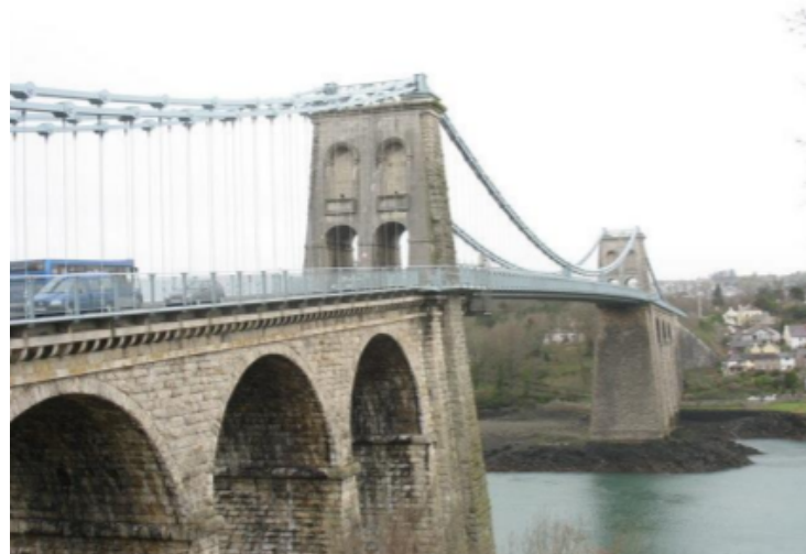
Figura 9 - Ponte suspensa Menai Strait, Reino Unido
