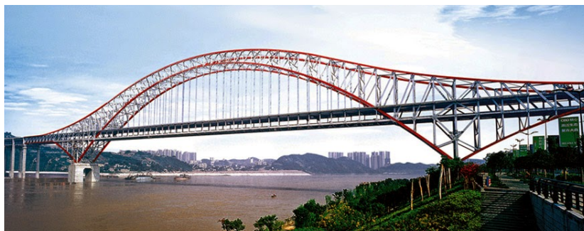
Figura 33 - Ponte Chaotianmen, na China
