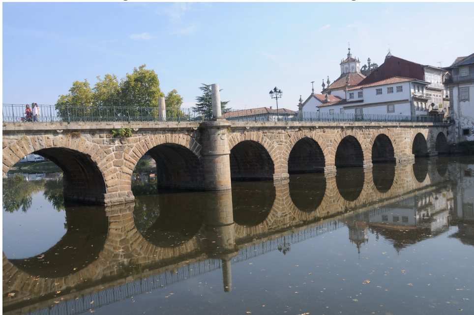
Figura 13 - Ponte de Chaves, em Portugal
