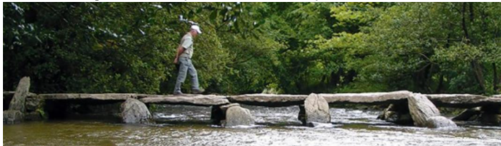
Figura 1 - Ponte pré-histórica Tarr Steps, Grã-Bretanha
