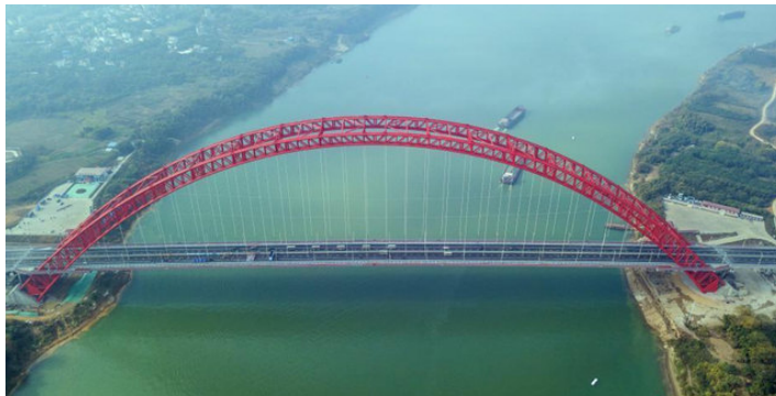
Figura 31 - Ponte Pingnan, na China
