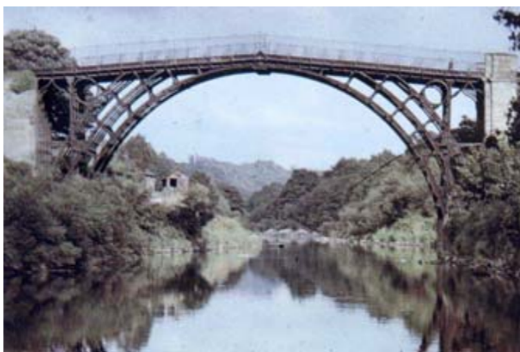
Figura 24 - Arco de Ferro Coalbrookdale
