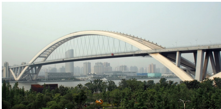
Figura 32 - Ponte Lupu, na China
