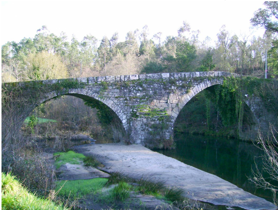
Figura 20 - Ponte Medieval de Vilela, em Portugal
