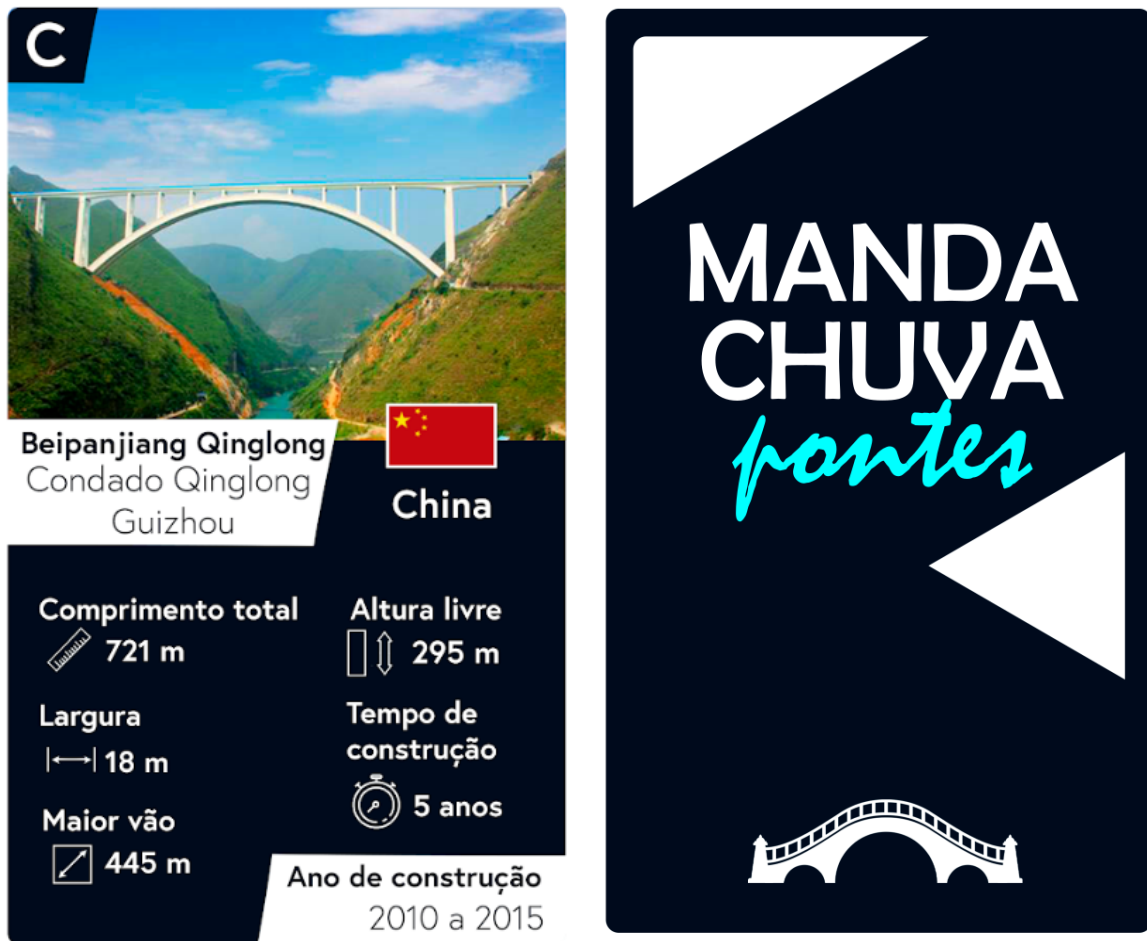
Figura 53 - Card da Ponte Ferroviária de Beipanjiang Qinglong
