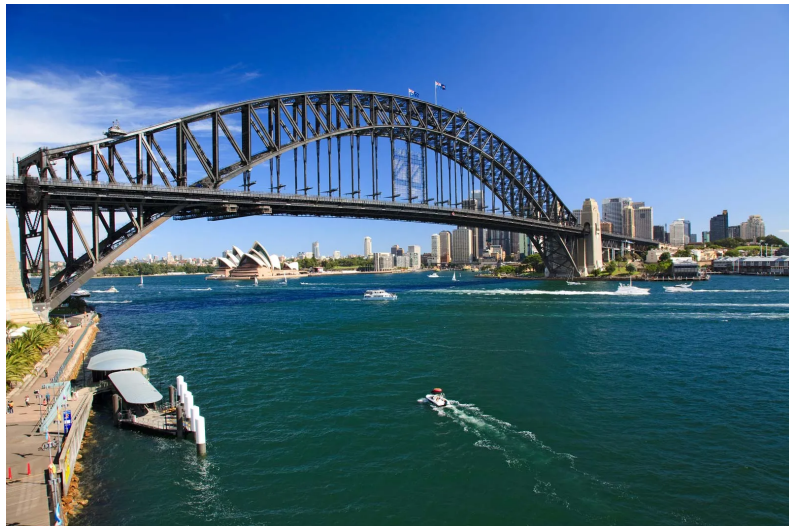
Figura 29 - Sydney Harbour Bridge, na Austrália
