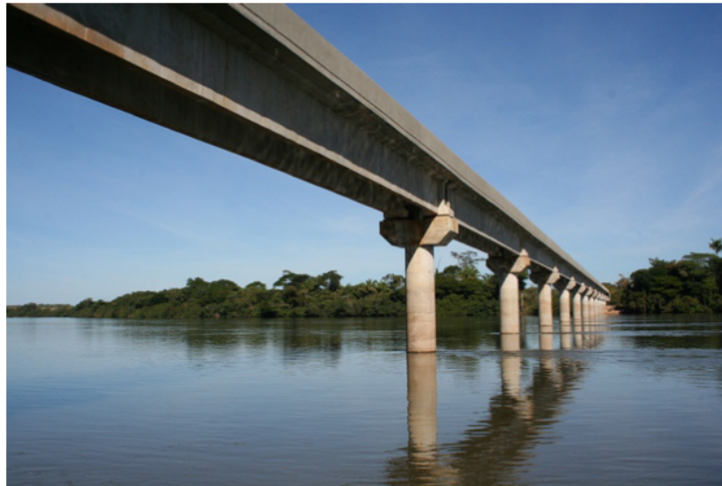
Figura 2 - Ponte em viga, Rio Teles Pires (MT)
