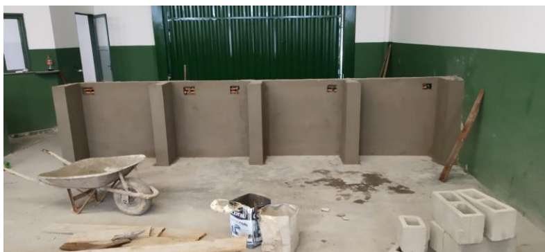
Fotografia 5 - Balcão em construção
