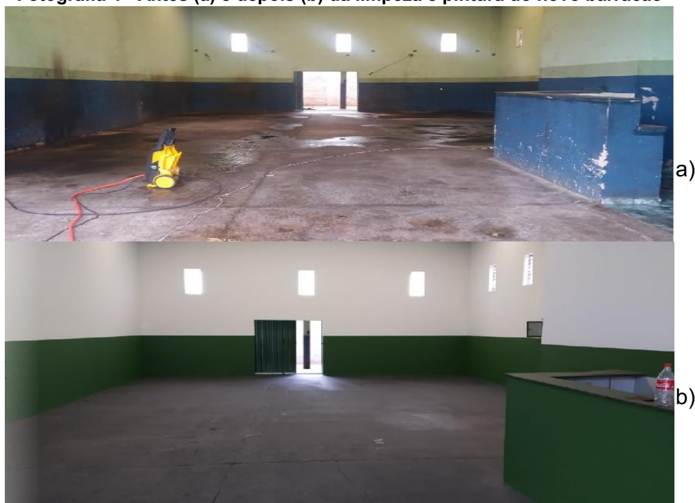
Fotografia 4 - Antes (a) e depois (b) da limpeza e pintura do novo barracão
